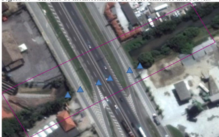
Figura 47 - Sistema de monitoramento de deslocamentos na rodovia.
