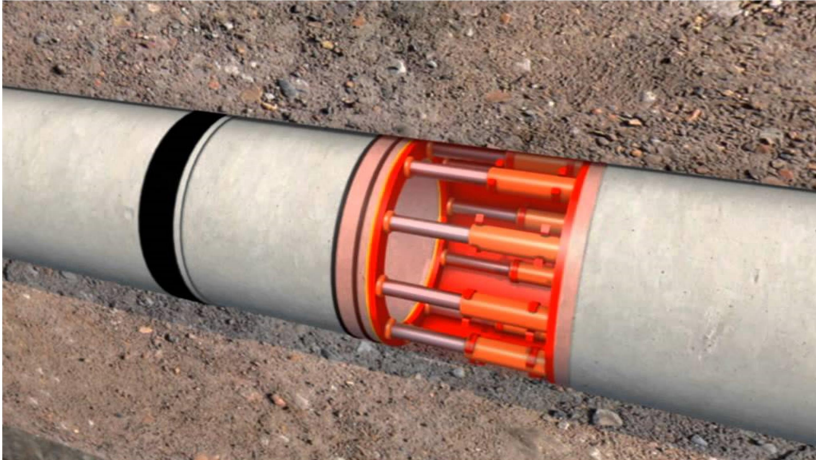
Figura 9 - Estação intermediária de propulsão.
