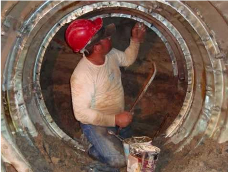
Figura 6 – Montagem das chapas metálicas.
