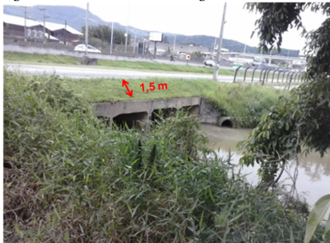
Figura 45 - Baixa cobertura sob a marginal da BR-101.
