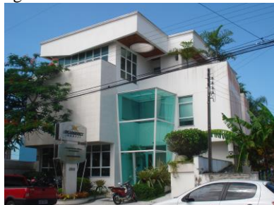
Figura 34 - Edifício antes da reforma.
