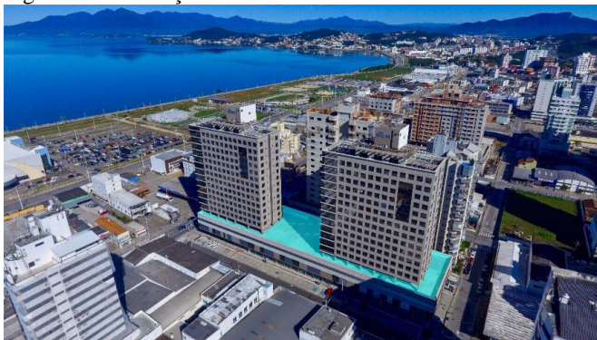
Figura 108 - Terraço entorno das duas torres do edifício.
