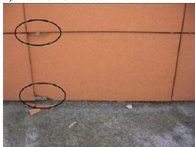
Figura 20 - Rupturas placas de revestimento em cerâmica extrudada.
