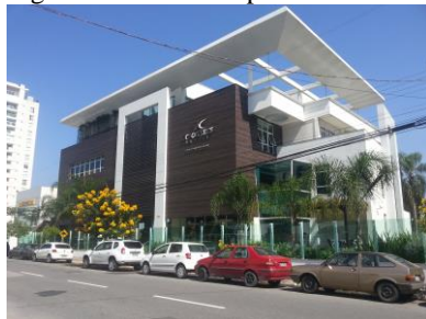
Figura 35 - Edifício após a reforma.
