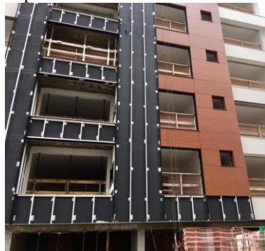
Figura 8 - Aplicação de membrana impermeabilizante.
