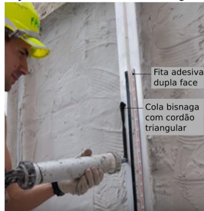
Figura 16 - Aplicação fita adesiva dupla face e os adesivos em bisnaga.
