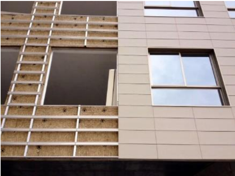
b) Ancragem das placas de cêramica extrudada na subestrutura intermediária.
