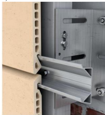
Figura 96 - Detalhes construtivos dos arremates das juntas.
