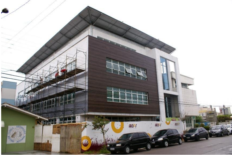
Figura 54 - Execução da fachada industrializada no estudo de caso A.
