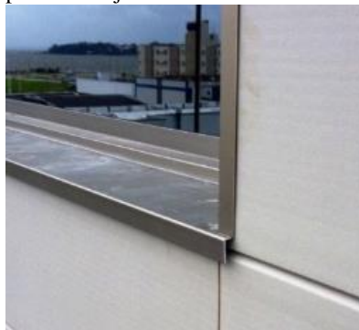
Figura 103 - Pingadeira metálica no peitoril das janelas.
