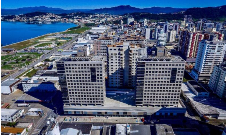
Figura 68 - Vista panorâmica da edificação.
