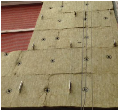
Figura 7 - Fixação do isolante térmico com buchas.
