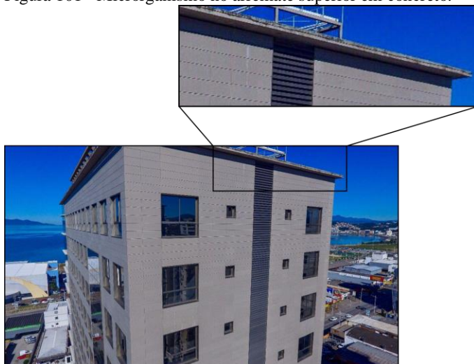
Figura 101 - Microrganismo no arremate superior em concreto.
