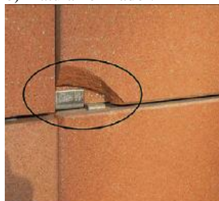
Figura 20 - Rupturas placas de revestimento em cerâmica extrudada.
