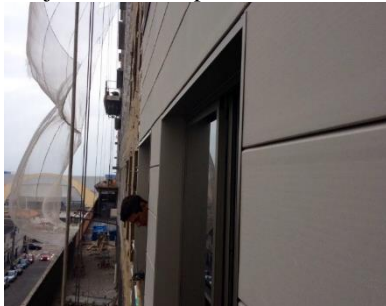
Figura 95 - Arremate do contorno das janelas em chapa metálica.
