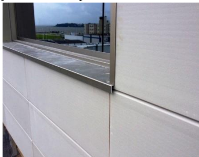
Figura 94 - Arremate do peitoril das janelas em chapa metálica.
