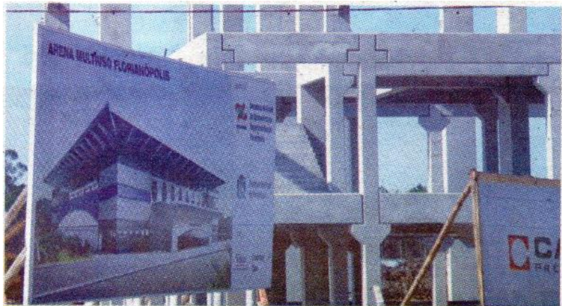
Obra. Esqueletos de concreto estão sendo erguidos. Fim previsto para 2011
