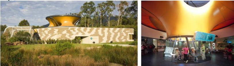
Figura 88 - Vistas exterior e interior do Australian Wildlife Health Centre, do arquiteto Paul Minifie, Austrália.
