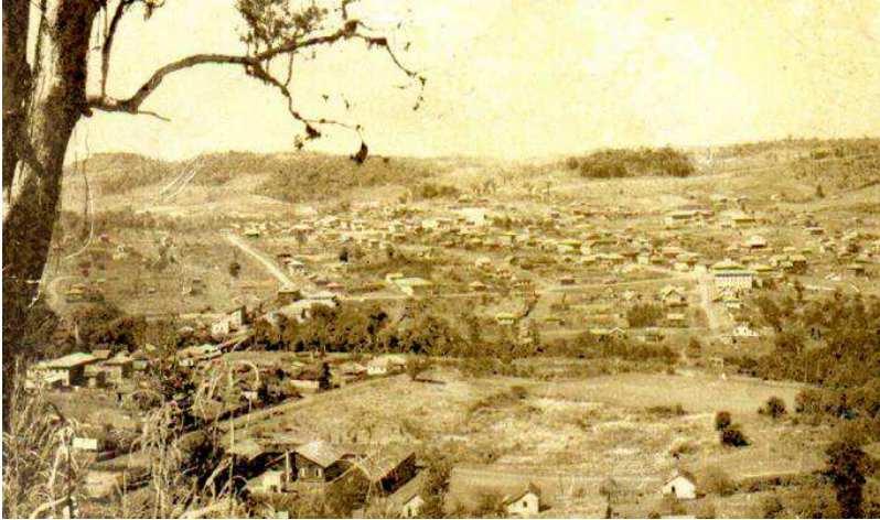
Figura 15. Vista da área central da cidade de Francisco Beltrão em 1952
