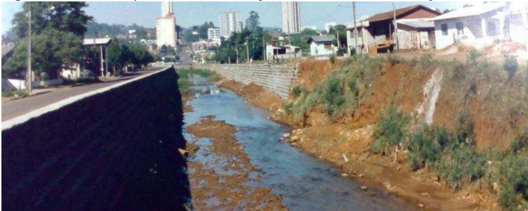
Figura 31 Rio Lonqueador, canalização em fase de construção em 1996.
