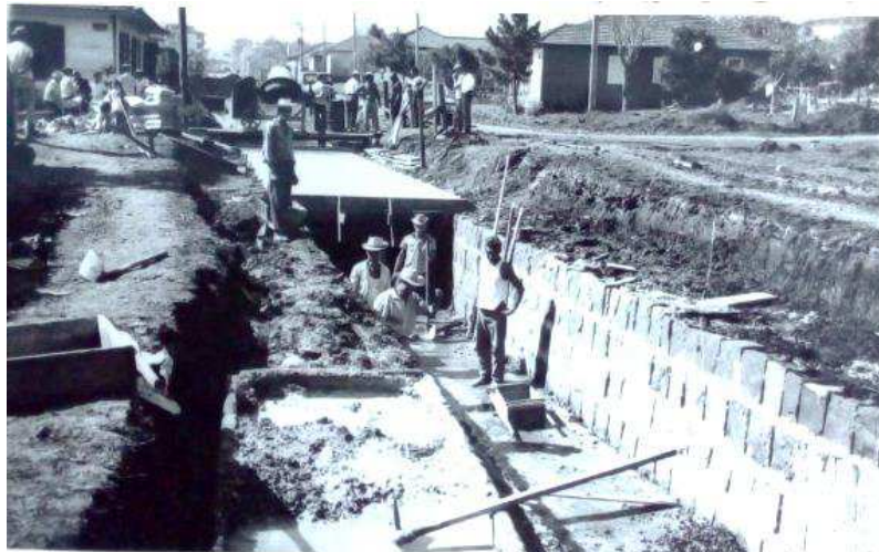
Figura 25 Canal da piscina, durante a canalização subterrânea.
