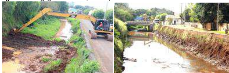
Figura 38 Dragagem Córrego Progresso e Urutago, 2014
