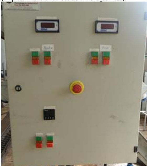
Figura 4.2 – Quadro de comando para controle de temperatura dos reatores piloto (empresa Transfertech Gestão e Inovação Ltda).
