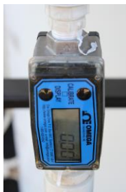
Figura 4.11– Medidor de vazão de água.
