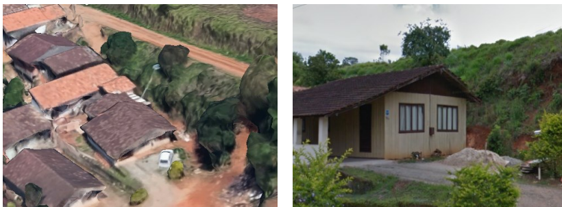
Figura 31 – Casa construída próxima a talude de corte desprotegido e com via a cima dele sem drenagem pluvial
