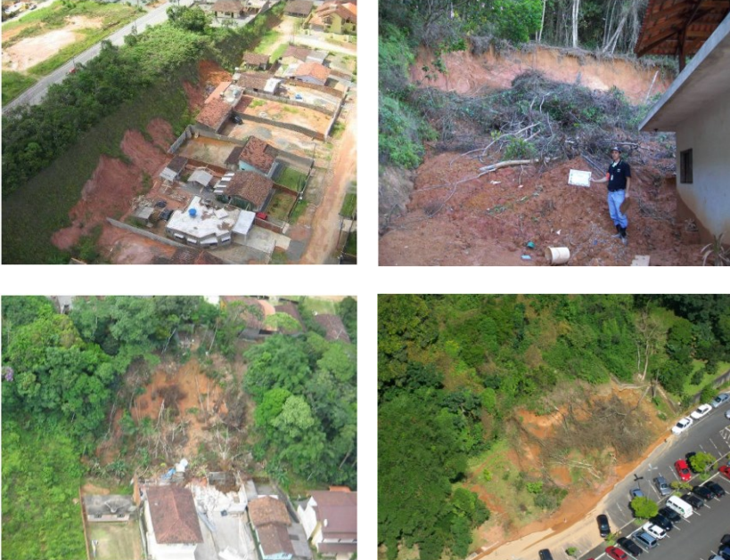
Figura 15 - Deslizamentos ocorridos em novembro de 2008
