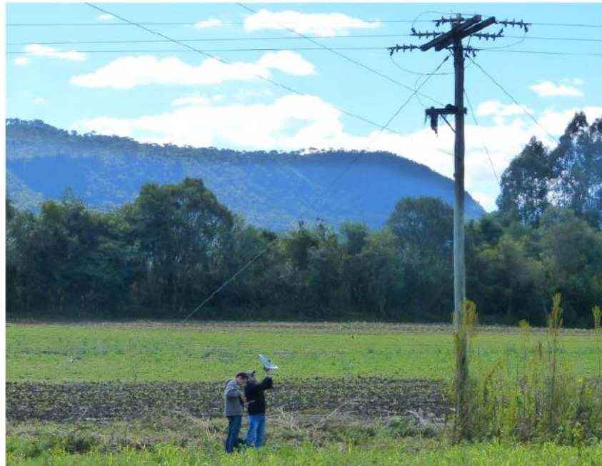
Figura 16: Inspeção elétrica com equipamento de ultrassom.
