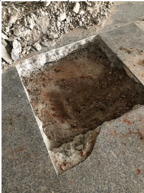
Figura 4.10 - Laje, contrapiso e piso existentes no local
