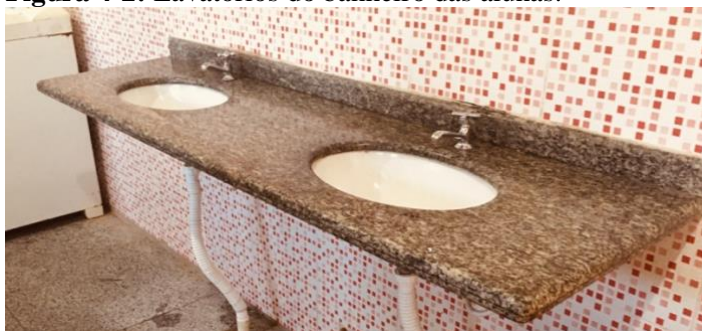
Figura 4-2: Lavatórios do banheiro das alunas.
