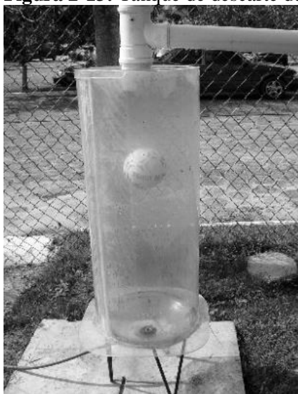
Figura 2-13: Tanque de descarte de primeiras águas.
