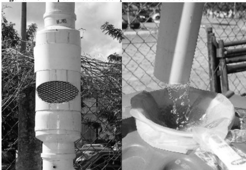
Figura 2-8: Dispositivos de retenção de materiais sólidos.
