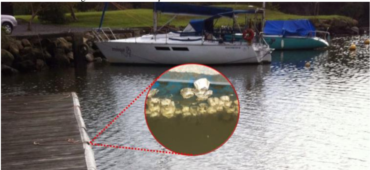
Figura 35 - Bioincrustação nos flutuadores da Marina Cubatão
