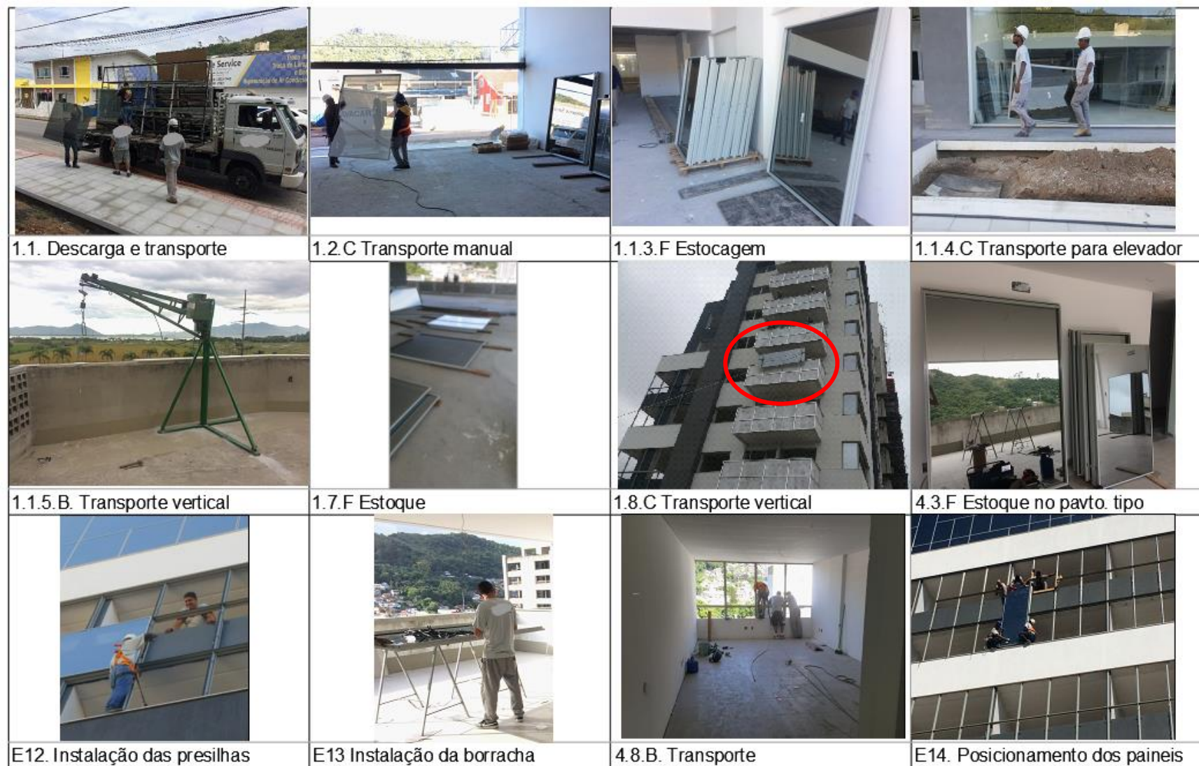
Figura 25 - Etapas registradas da execução de fachada cortina.
