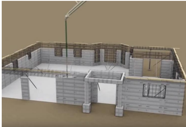
Figura 18 - Concretagem de paredes de residência com formas metálicas
