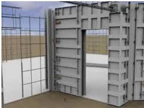
Figura 13 - Exemplo de montagem de formas e armaduras
