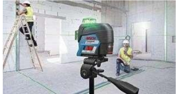
Figura 4-36 - Nivelamento com nível a laser.
