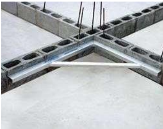
Figura 4-41 - Verificação do esquadro entre paredes.
