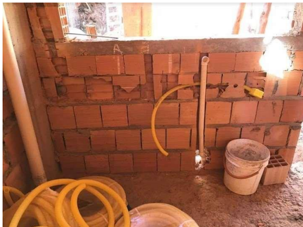
Figura 2-3 - Instalações na alvenaria.
