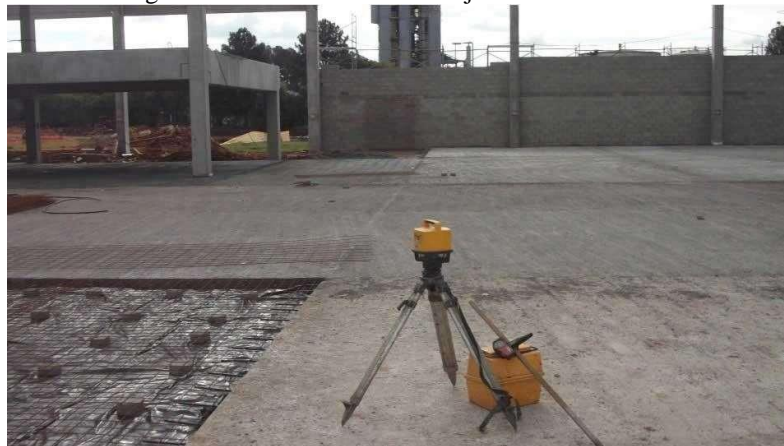
Figura 4-12 - Nivelamento da laje com nível alemão.
