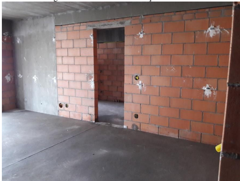
Figura 2-1 - Alvenaria de vedação tradicional.
