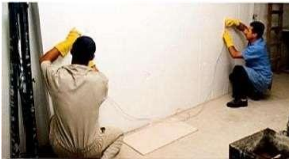
Figura 4-35 - Nivelamento com nível de mangueira.
