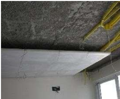
Figura 4-46 - Passagem de tubulação por baixo de forro.
