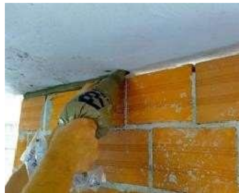
Figura 4-9 – Fixação com argamassa expansiva.
