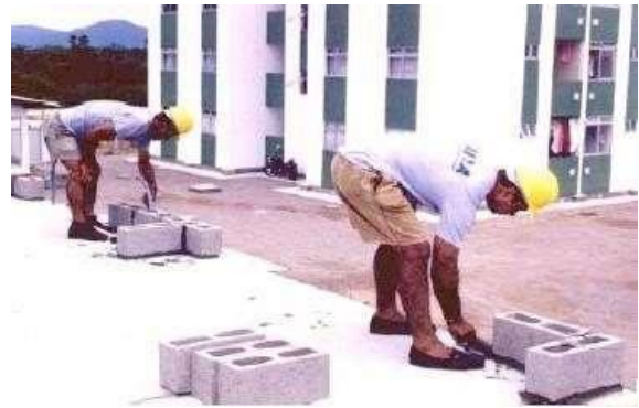
Figura 4-16 – Assentamento dos blocos dos cantos extremos.
