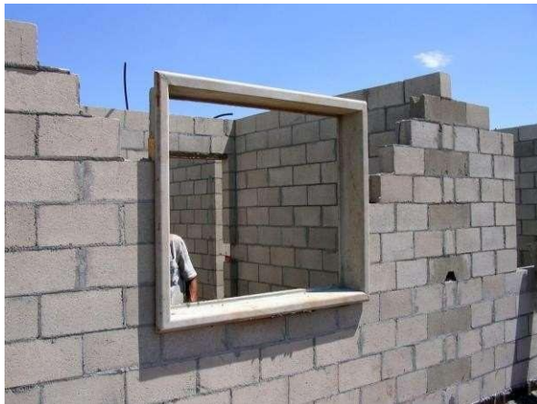
Figura 4-32 - Contramarco de concreto pré-moldado.
