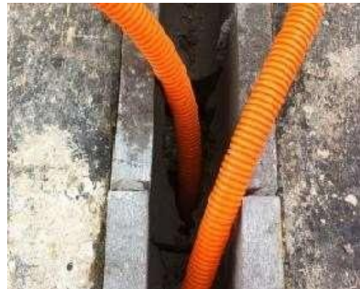
Figura 4-47 - Passagem de tubulação por bloco canaleta.
