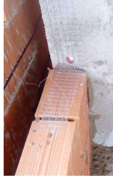
Figura 4-57 - Comprimento de ancoragem abaixo do recomendado.
