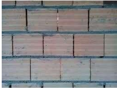
Figura 4-24 – Juntas verticais secas.
