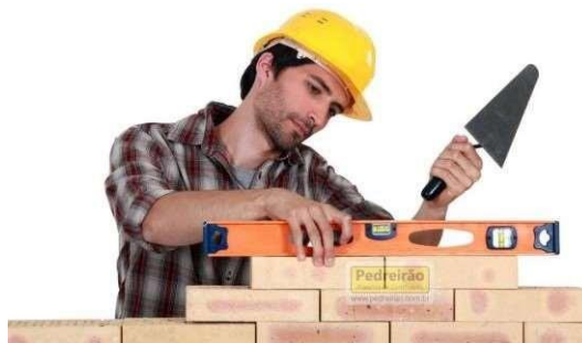
Figura 4-37 – Nivelamento com nível de bolha.
