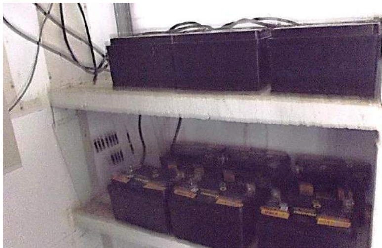
Figura 4.15 Banco de baterias da iluminação de emergência.
