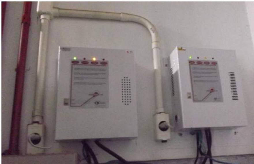
Figura 4.15 Banco de baterias da iluminação de emergência.
