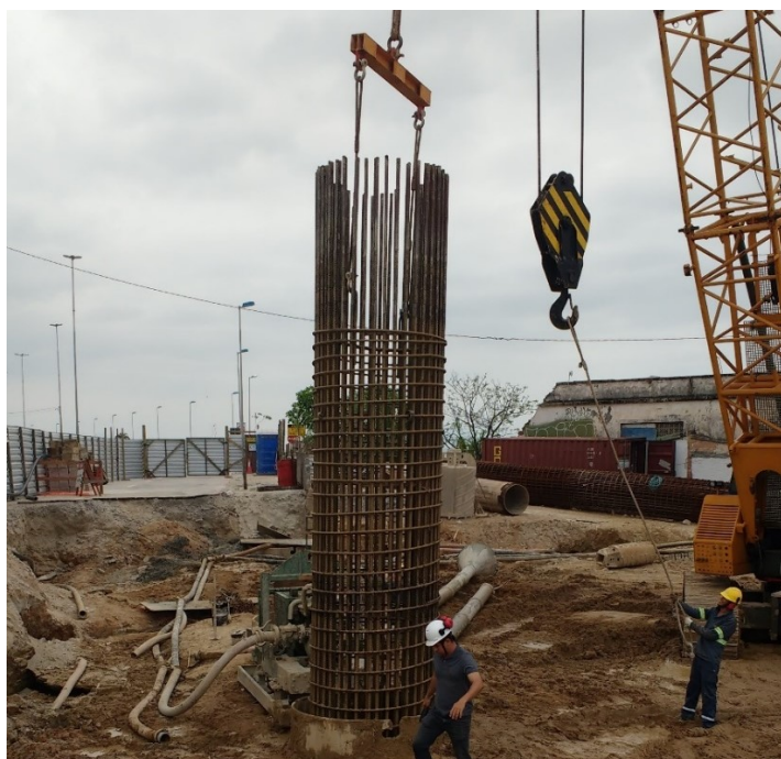
Figura 38 – Posicionamento da armadura no furo da estaca.
