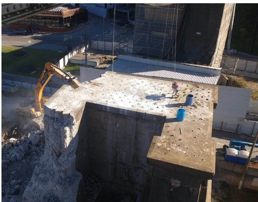
Figura 35 – Desmonte do maciço de ancoragem continental
