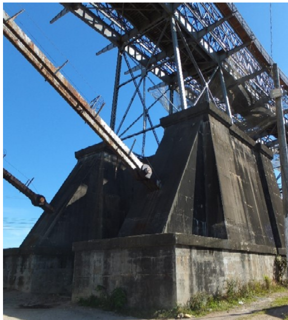
Figura 22 – Maciço de ancoragem continental original
