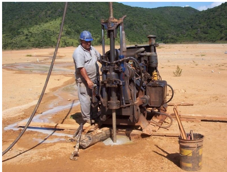
Figura 8 - Equipamento realizando a extração de testemunho.
