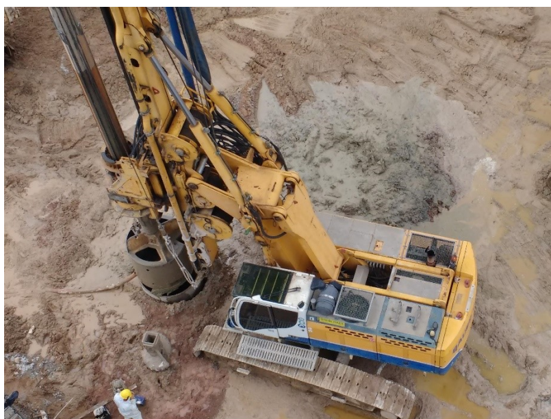
Figura 37 – Guindaste de esteira com mesa rotatória realizando escavação.
