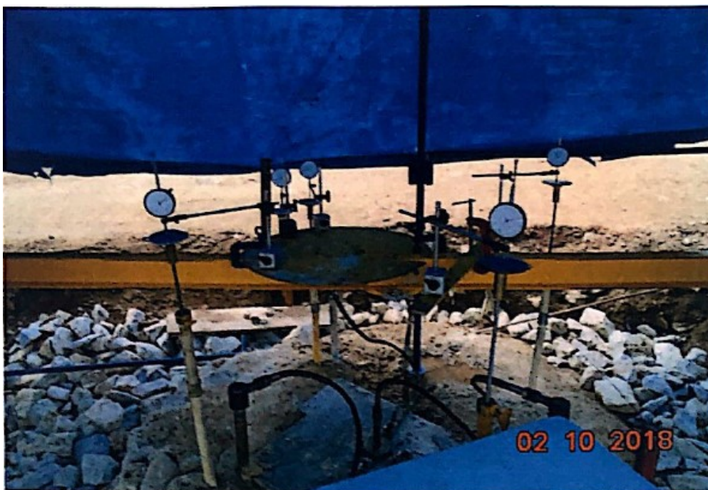
Figura 45 – Instrumentação da estaca durante a prova de carga
