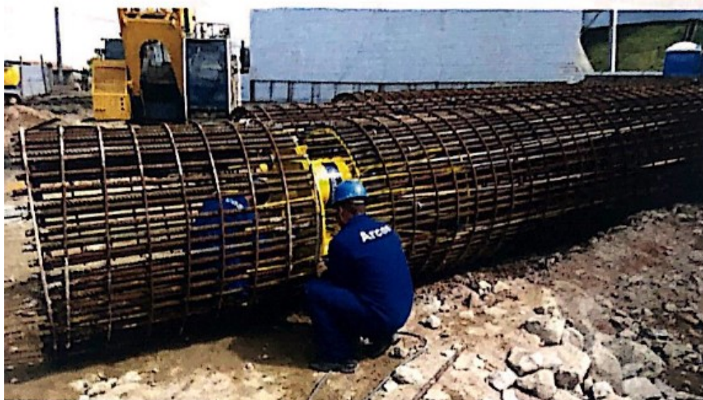
Figura 44 – Procedimento de instalação das células na estaca
