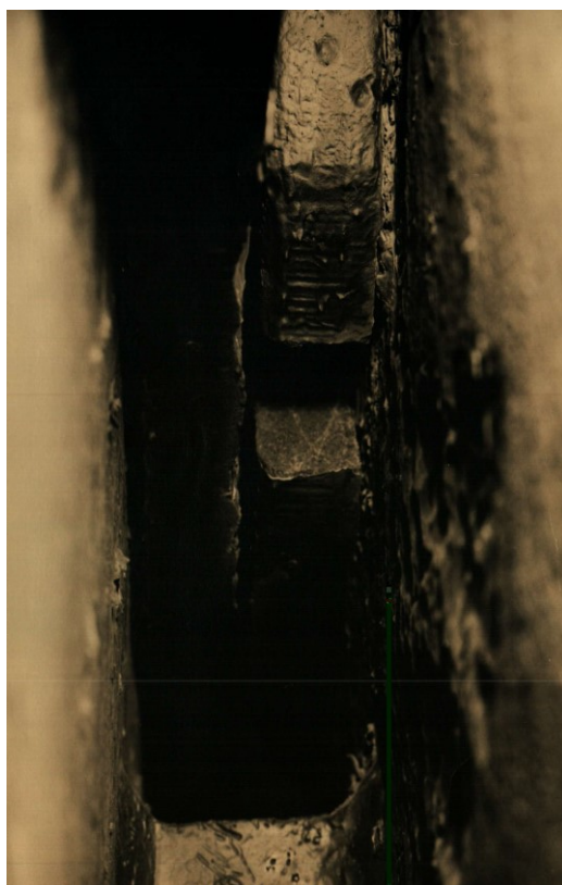
Figura 21 – Barra de olhal rompida na cela da torre 8, lado sul
