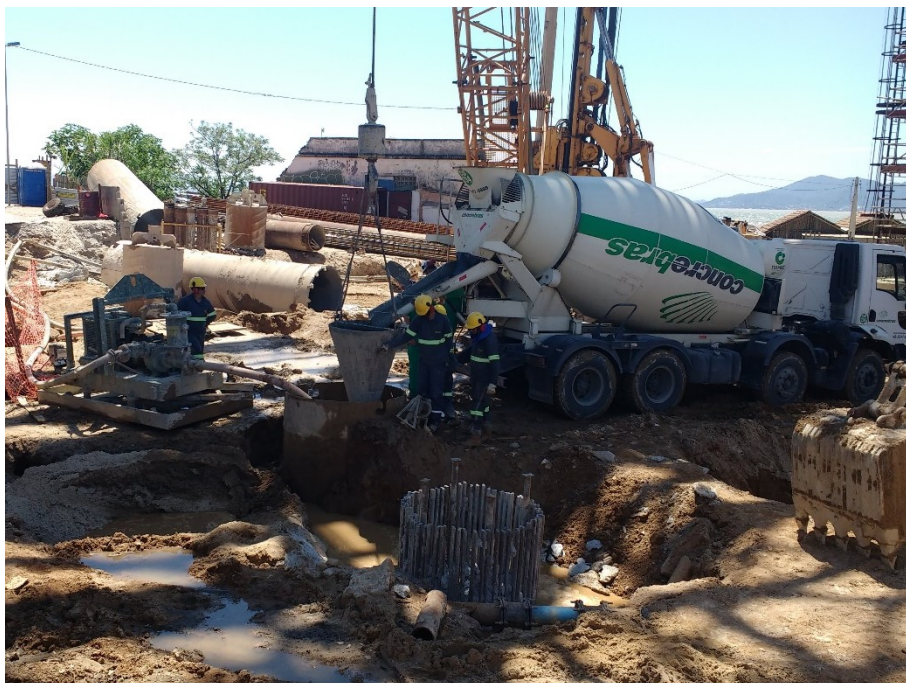
Figura 39 – Concretagem da estaca com emprego da tremonha.
