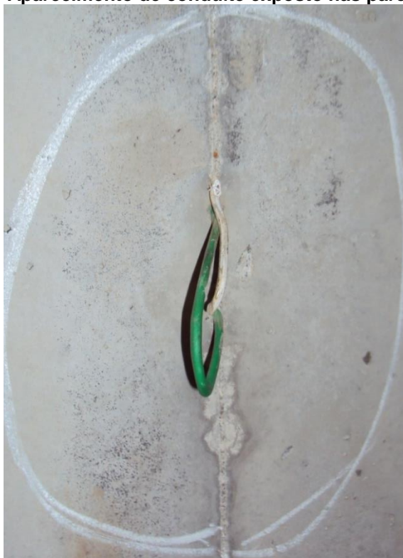
Figura 48 - Aparecimento de conduíte exposto nas paredes
