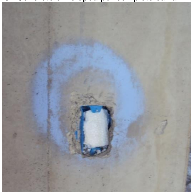
Figura 49 - Concreto envelopou por completo caixa 4x2
