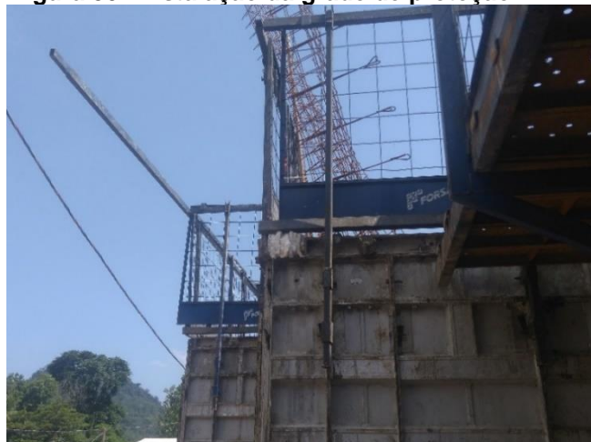
Figura 30 - Instalação da grade de proteção
