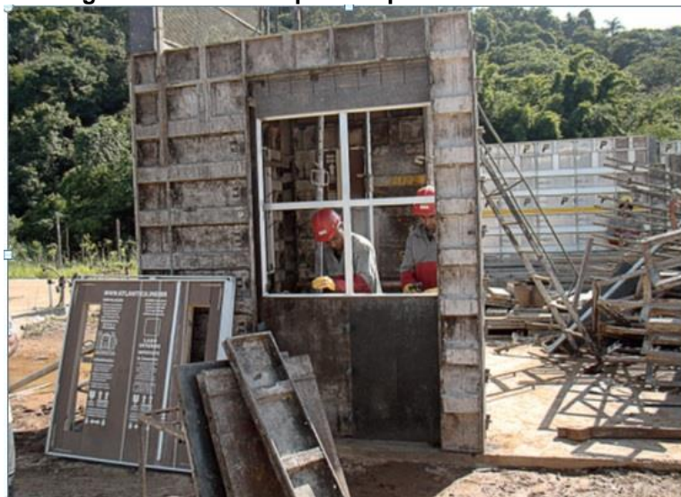
Figura 18 - Abertura para esquadria sendo travada
