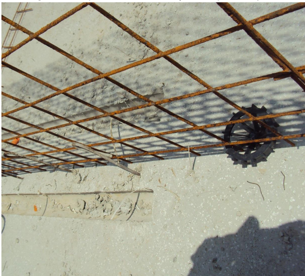
Figura 22 - Tela posicionada com amarração nas esperas da laje
