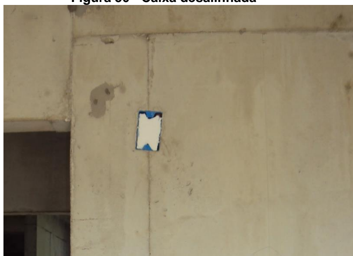
Figura 50 - Caixa desalinhada
