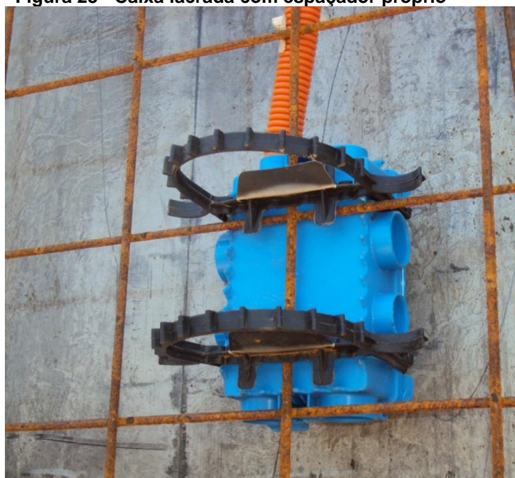
Figura 23 - Caixa lacrada com espaçador próprio
