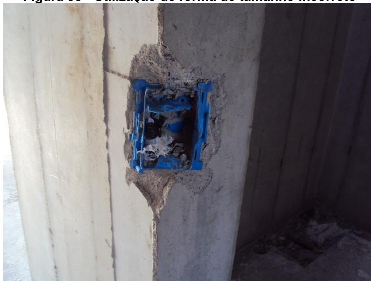
Figura 53 - Utilização de fôrma de tamanho incorreto
