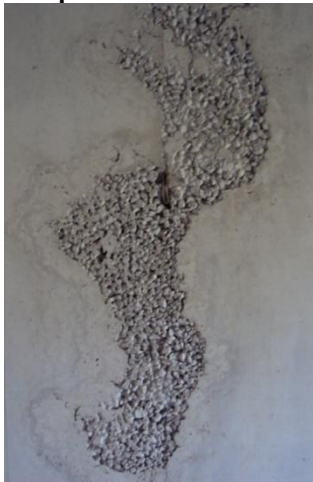
Figura 37 - Aparecimento do agregado graúdo na parede de concreto
