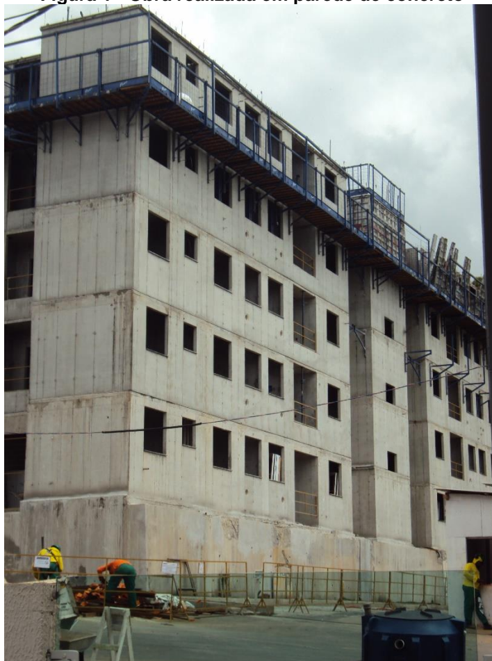
Figura 1 - Obra realizada em parede de concreto
