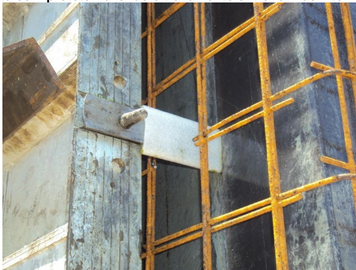
Figura 28 - Faqueta com protetor fazendo o travamento entre fôrmas interna e externa
