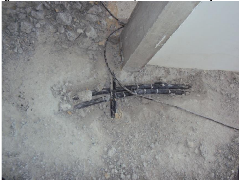
Figura 52 - Afloramento da instalação hidráulica da laje
