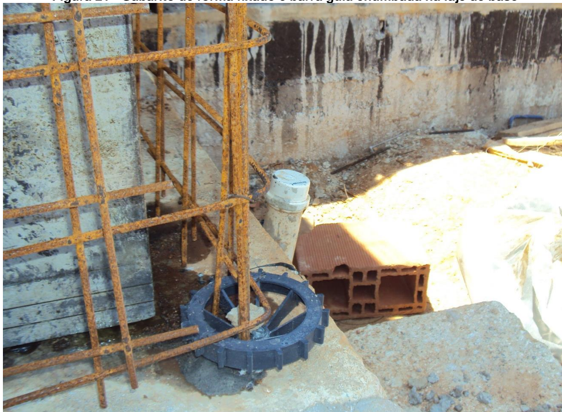
Figura 21 - Gabarito de fôrma fixado e barra guia chumbada na laje de base
