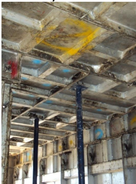
Figura 27 - Fôrmas de laje devidamente escoradas
