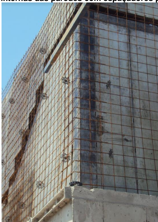
Figura 25 - Fôrmas internas das paredes com espaçadores posicionados
