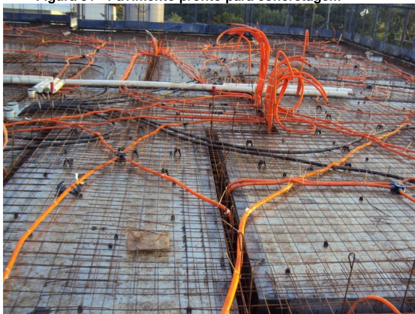
Figura 31 - Pavimento pronto para concretagem
