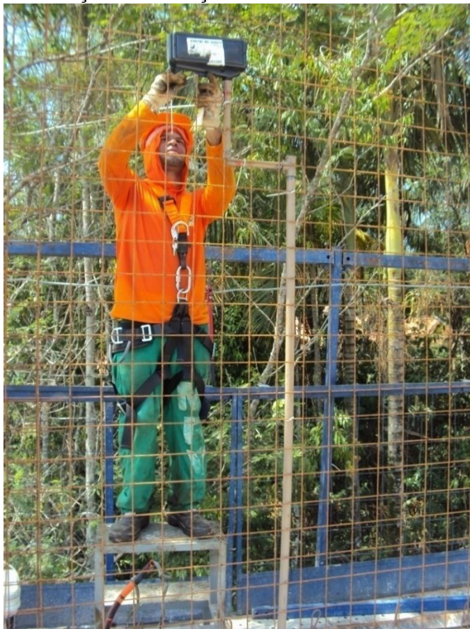
Figura 24 - Instalação da tubulação do dreno do Ar condicionado
