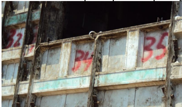
Figura 26 - Travamento das fôrmas das paredes por meio de pinos e ganchos
