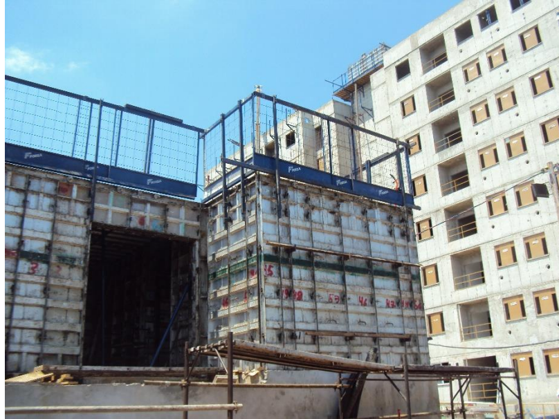
Figura 58 - Ligação de fôrma e guarda corpo
