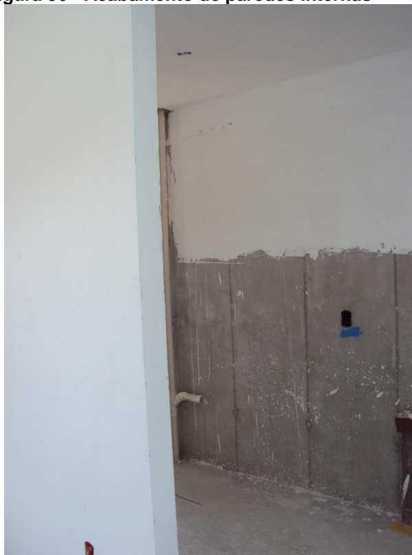
Figura 56 - Acabamento de paredes internas
