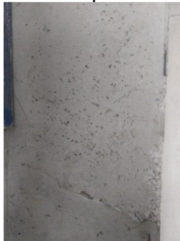
Figura 36 - Porosidade nas paredes de concreto
