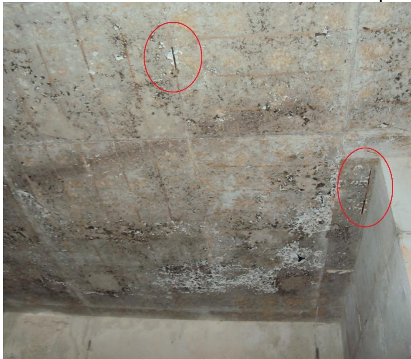
Figura 42 - Em vermelho estão destacados os locais com armadura aparente
