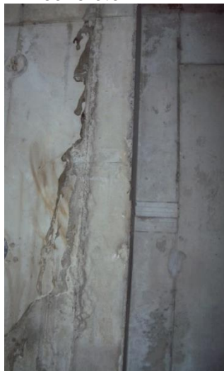
Figura 34 - Irregularidades na parede de concreto
