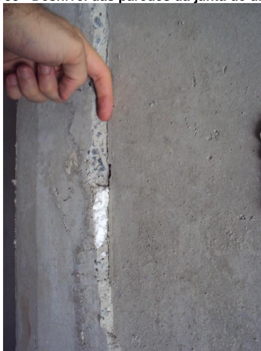
Figura 55 - Desnível das paredes da junta de dilatação
