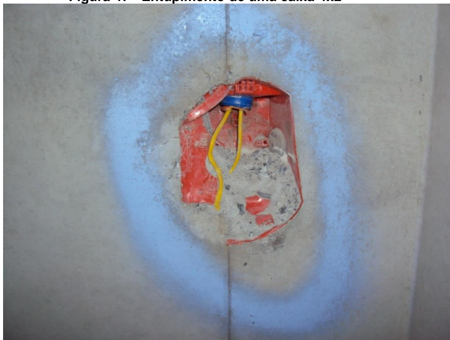
Figura 47 - Entupimento de uma caixa 4x2
