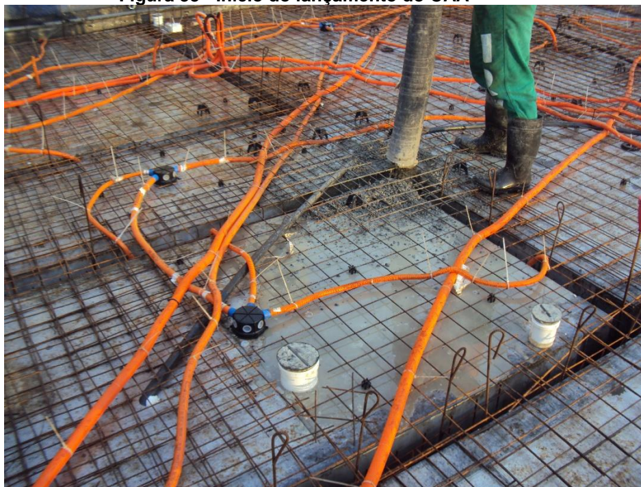
Figura 33 - Início do lançamento do CAA
