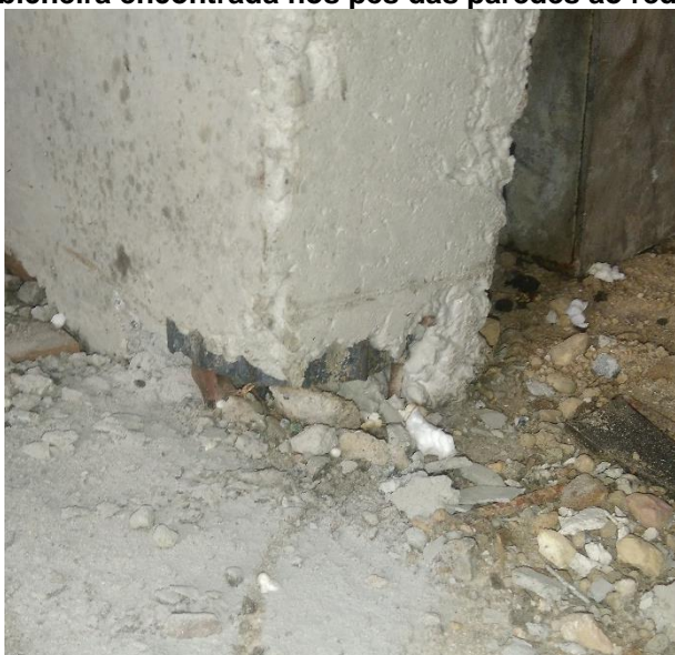
Figura 39 - Pequena bicheira encontrada nos pés das paredes ao redor do gabarito
