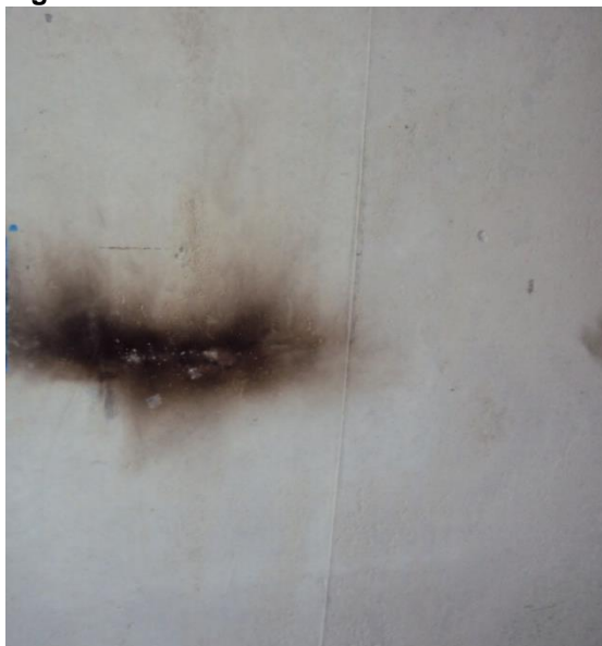
Figura 43 - Excesso de desmoldante
