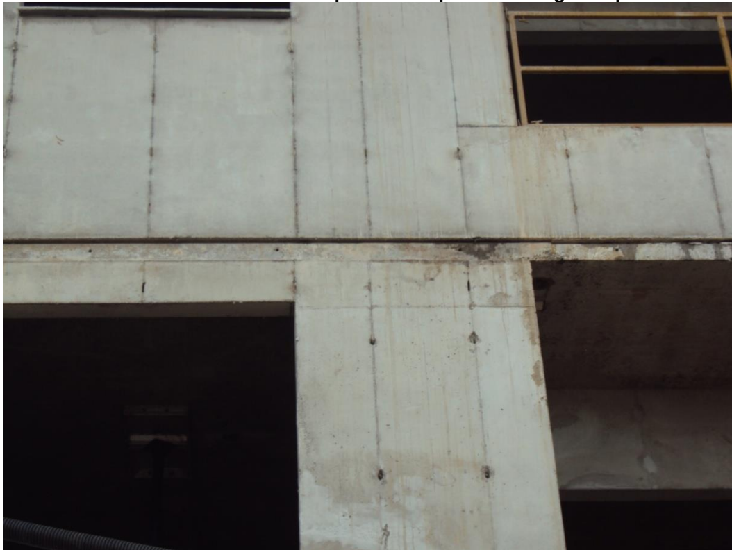
Figura 45 - Desalinhamento vertical entre paredes do primeiro e segundo pavimento
