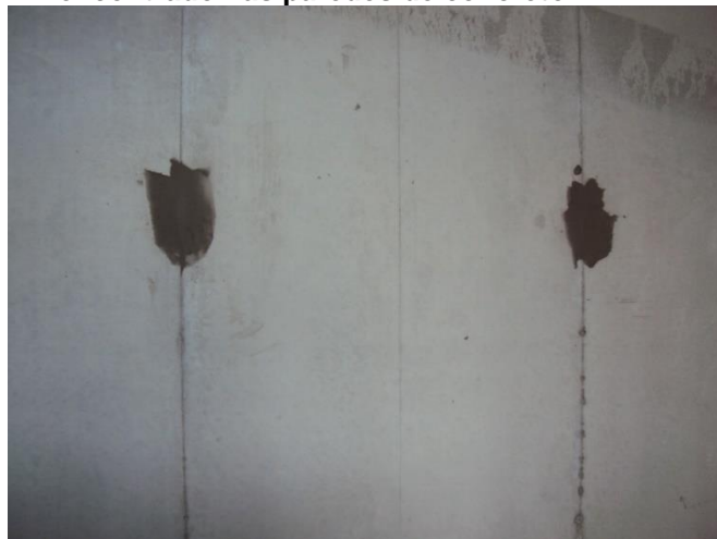
Figura 35 - Acabamento mais comum encontrado nas paredes de concreto
