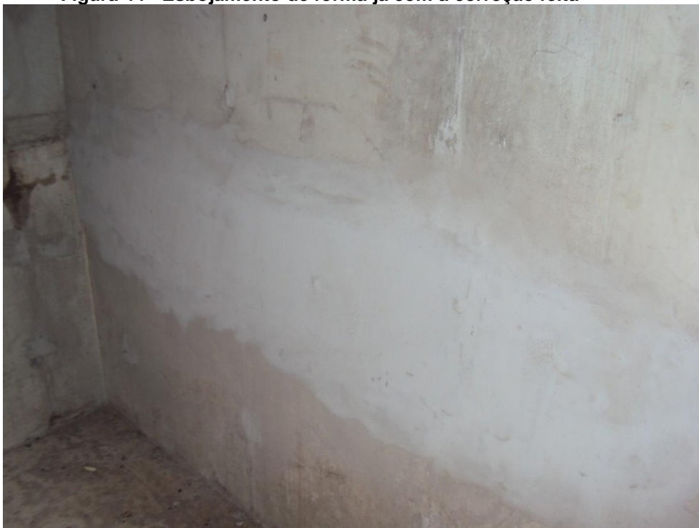
Figura 44 - Esbojamento de fôrma já com a correção feita
