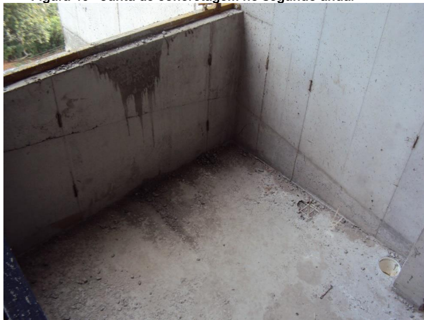
Figura 46 - Junta de concretagem no segundo andar
