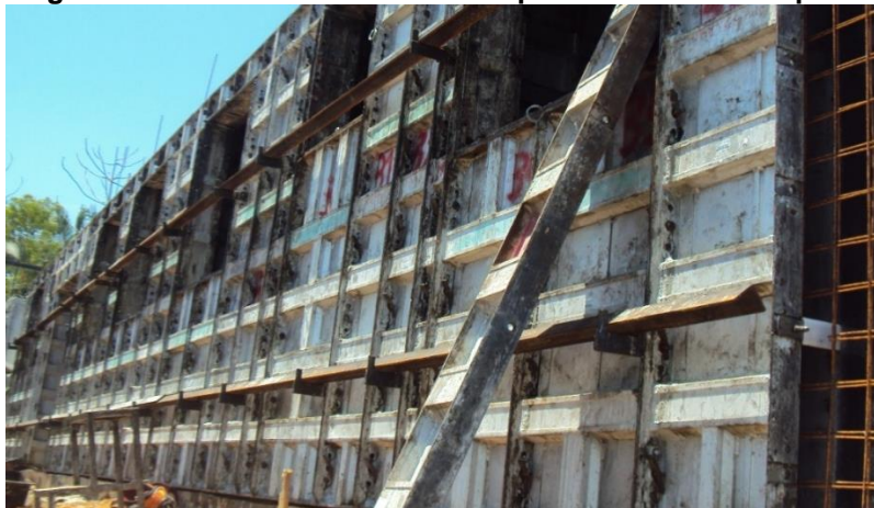
Figura 12 - Cantoneiras horizontais para travamento da parede
