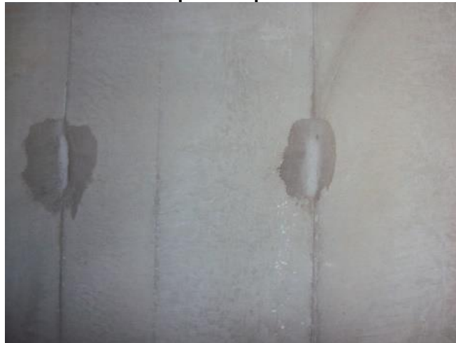
Figura 38 - Fechamento das aberturas deixadas pelas faquetas
