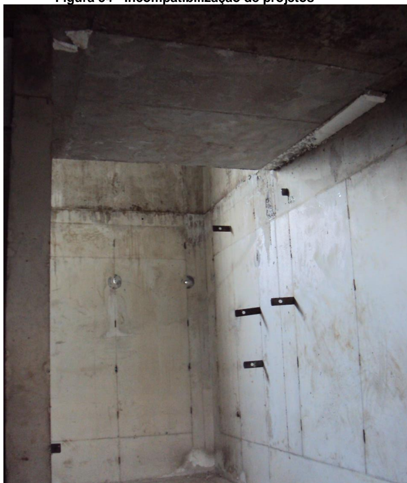
Figura 54 - Incompatibilização de projetos
