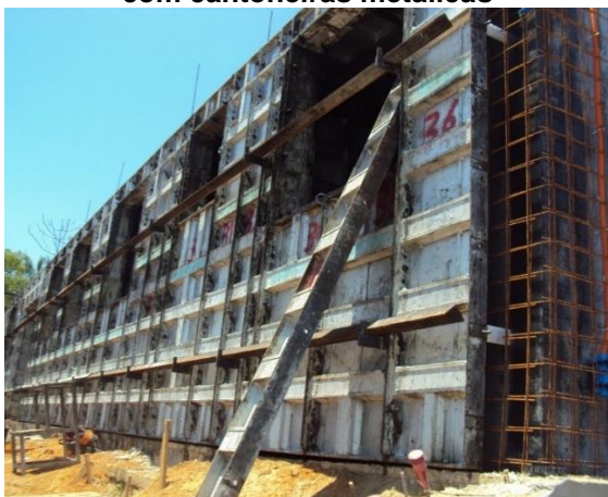
Figura 29 - Travamento da parede externa com cantoneiras metálicas
