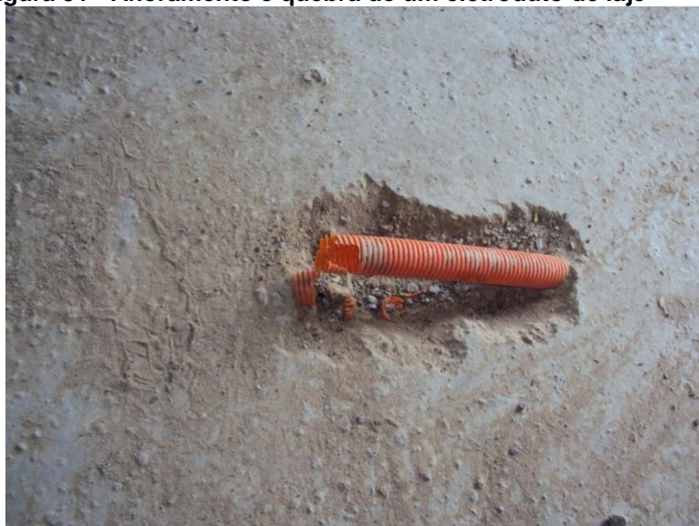
Figura 51 - Afloramento e quebra de um eletroduto de laje
