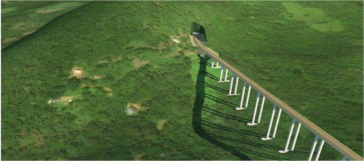
Túnel 9 e Viaduto 10
