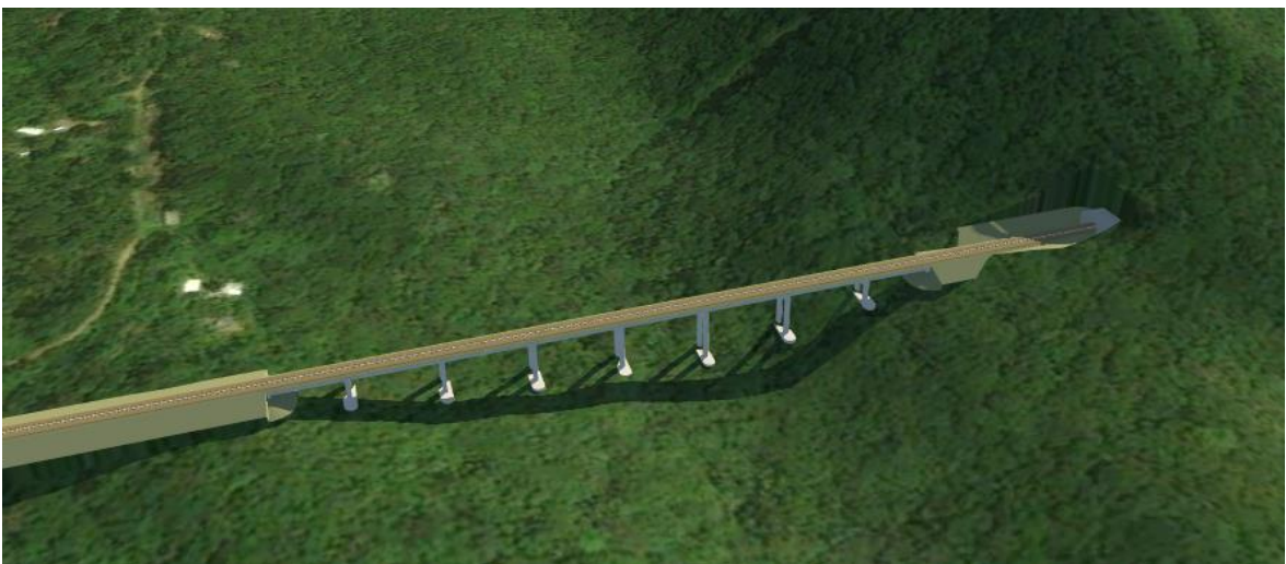
Túnel 8 e Viaduto 9
