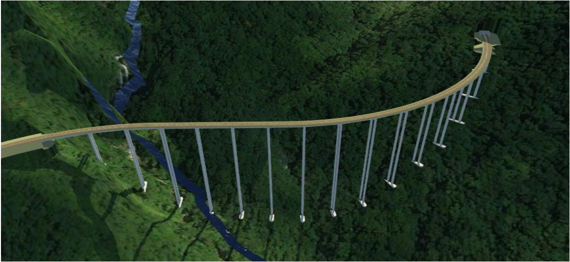
Túnel 4 e Ponte 4
