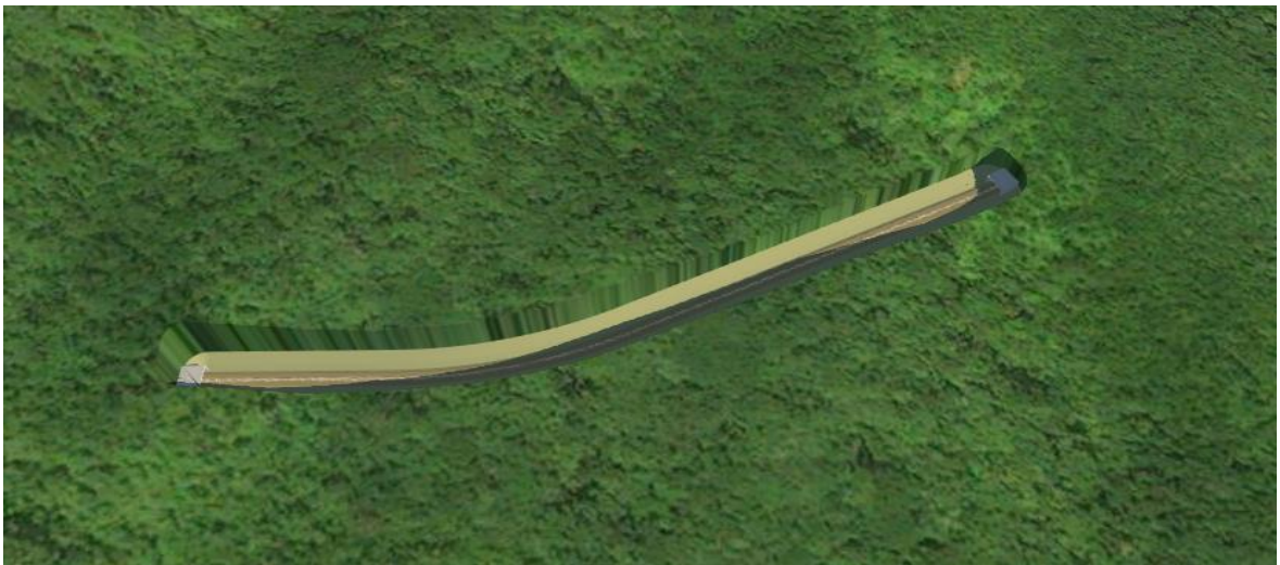
Túnel 12 e Túnel 13
