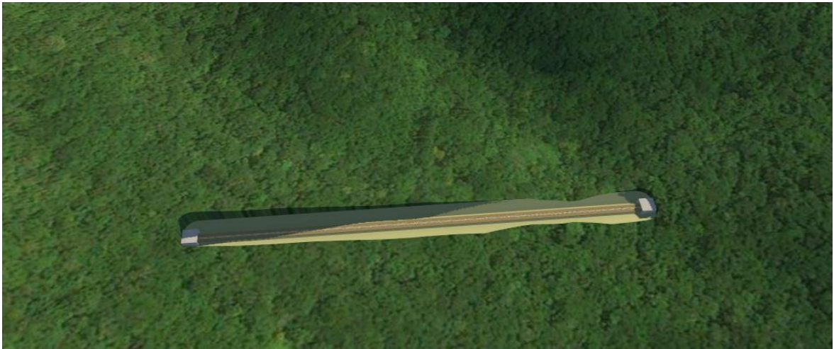
Túnel 7 e Túnel 8
