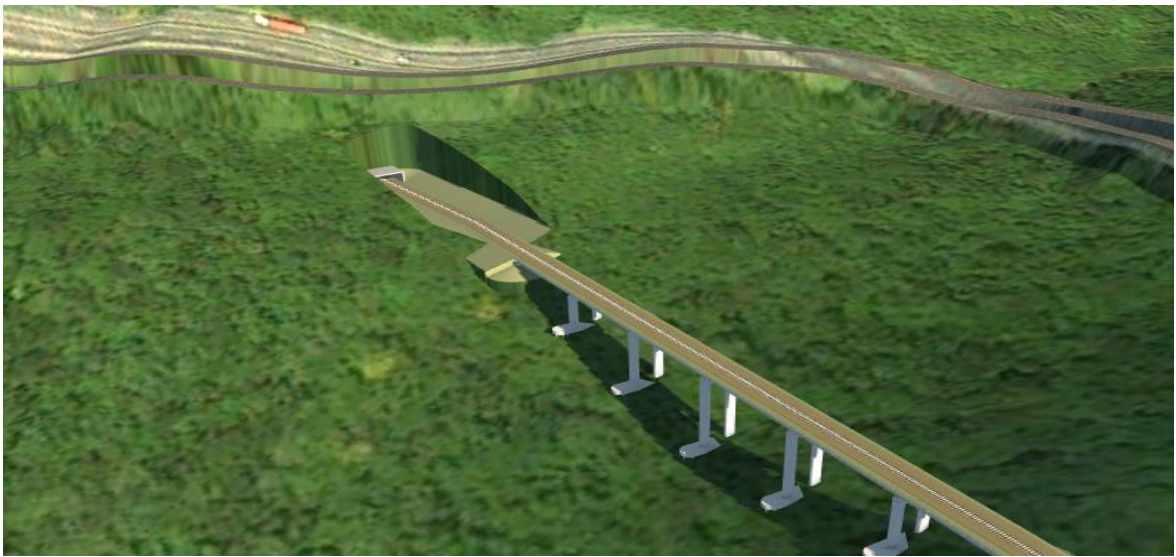
Viaduto 7 e Túnel 5
