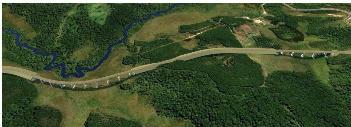
Ponte 2 e Viaduto 1
