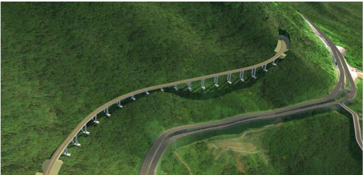
Túnel 5 e Viaduto 8
