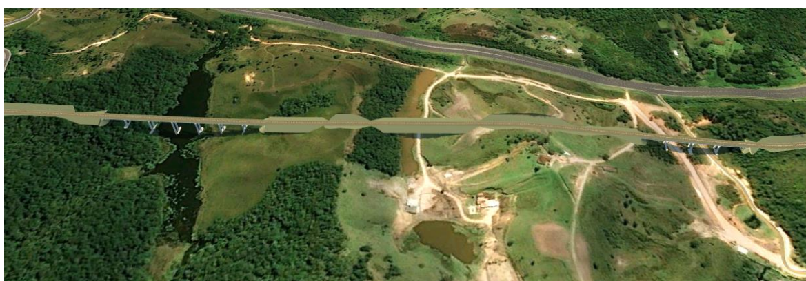
Ponte 3 e Viaduto 2
