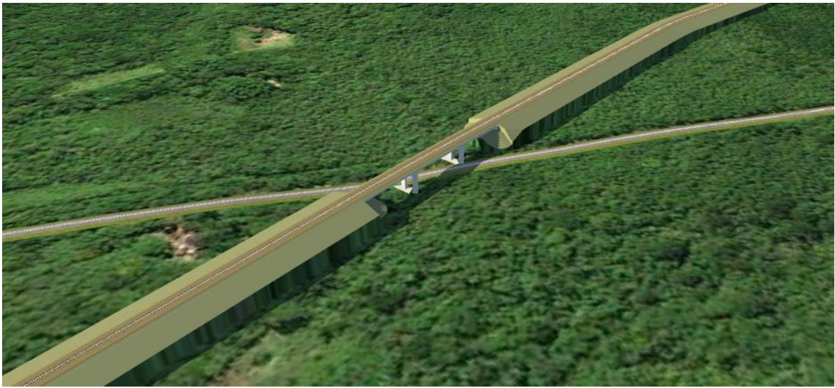
Viaduto 15 e Cruzamento com a ferrovia operada pela Rumo
