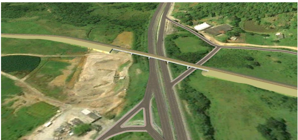
Viaduto 14 e Cruzamento com a BR-277
