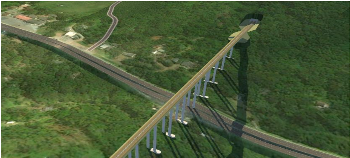
Viaduto 10, Cruzamento com a BR-277 e Túnel 10
