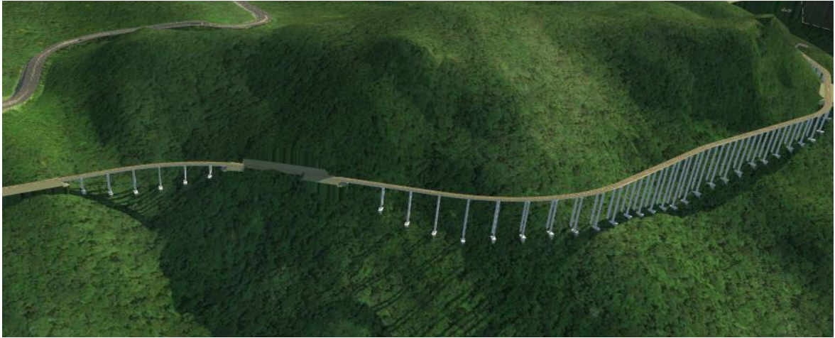
Viaduto 5 e Viaduto 6
