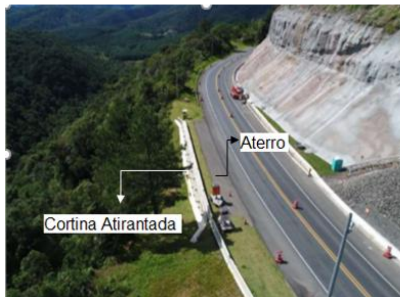
Figura 28: Imagem real do local da obra.
