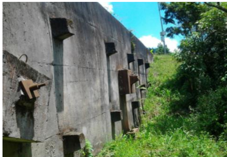
Figura 29: Imagem real da antiga cortina atirantada.
