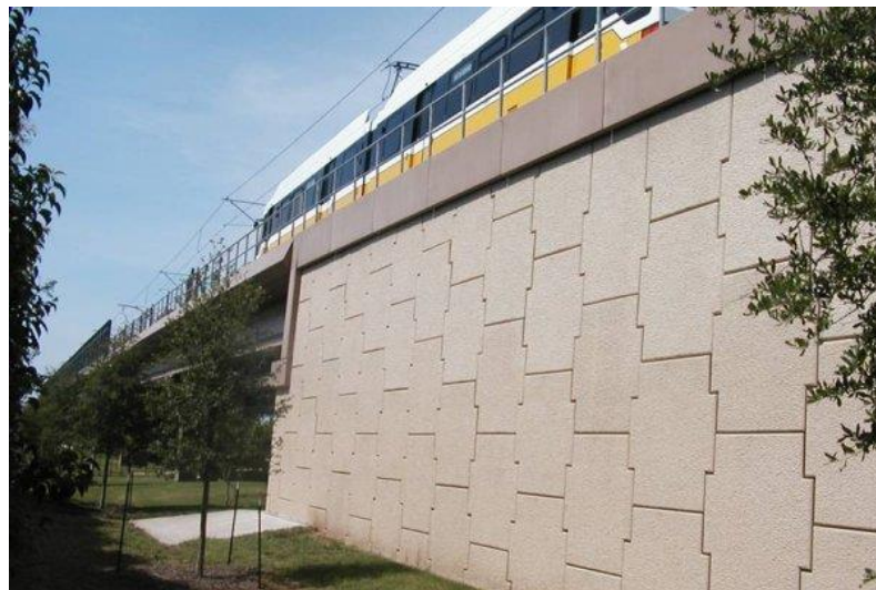
Figura 8: Painéis Cruciformes de faceamento de solo reforçado
