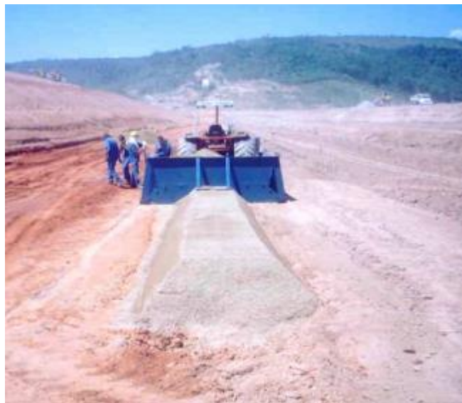
Figura 23. Filtro vertical de areia, em construção.
