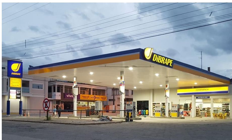
Figura 34 – Auto Posto de Luca Reformado
