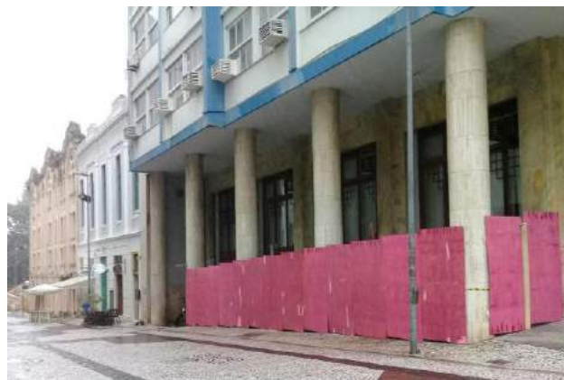
Imagem 3 - Prédio da Previdência Social com os tapumes
