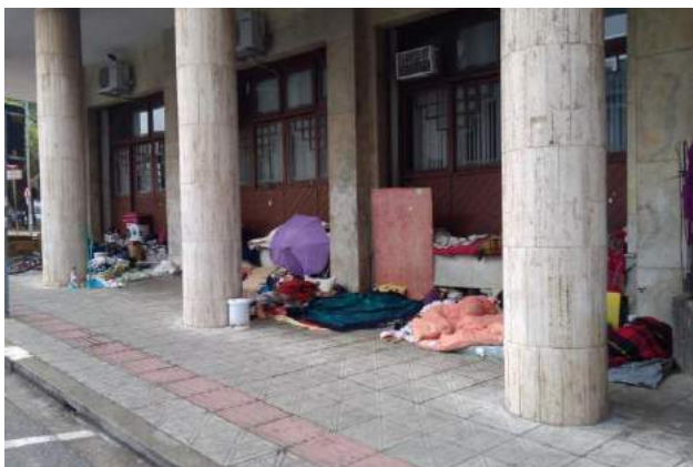
Imagem 2 - Prédio da Previdência Social antes dos tapumes
