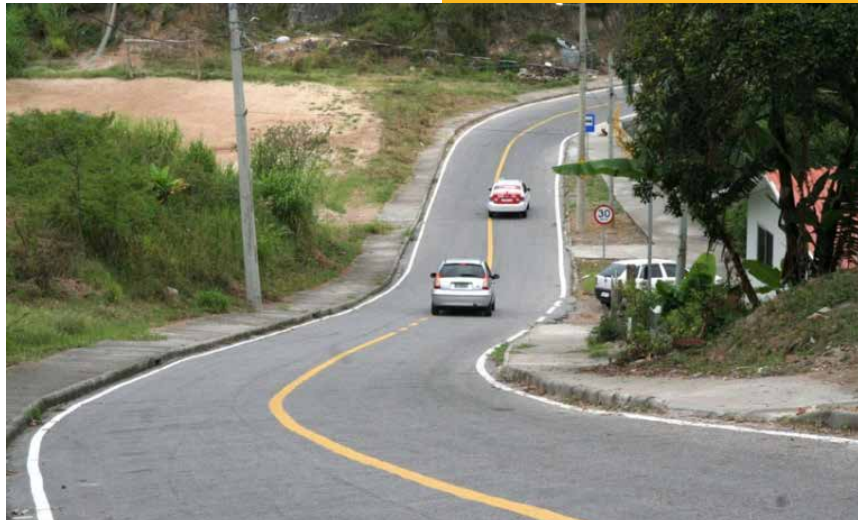
Figura 16. Rua Dois após as obras do PAC
