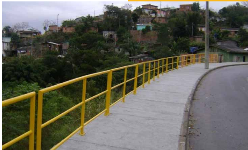
Figura 17. Ação do programa de contenção de deslizamentos e segurança nas vias do Morro
