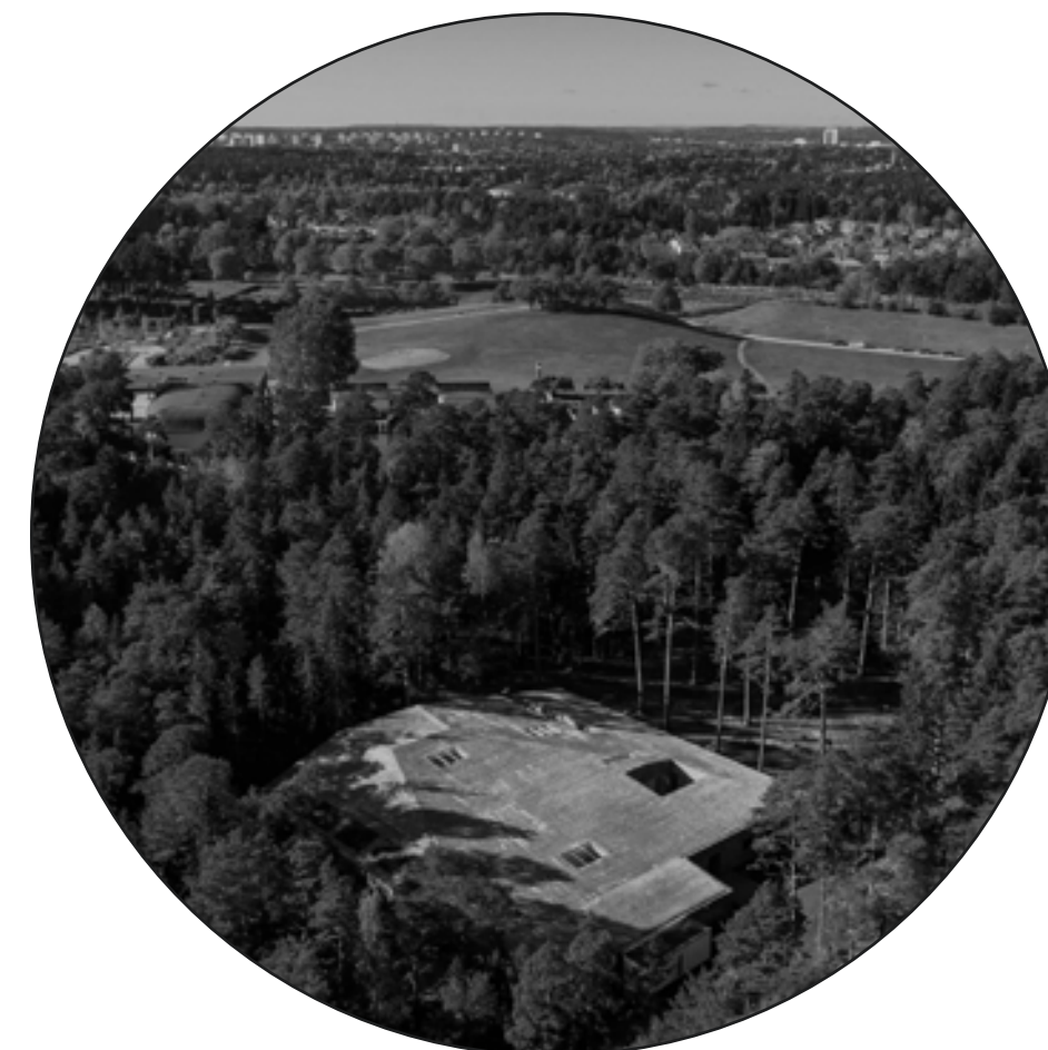
Figura 17: Novo crematório do Cemitério de Woodland
