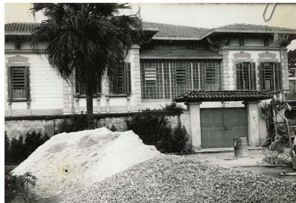
Figura 09 - Edifício em reforma para o abrigo do Presídio de Mulheres, 1941. Fonte: ARTUR, 2017.
