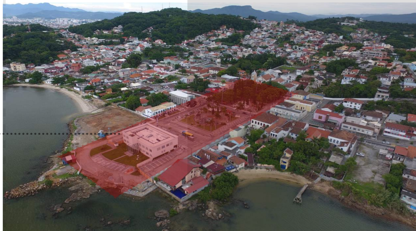
Vista aérea área de diagnóstico. (fonte: acervo próprio)
