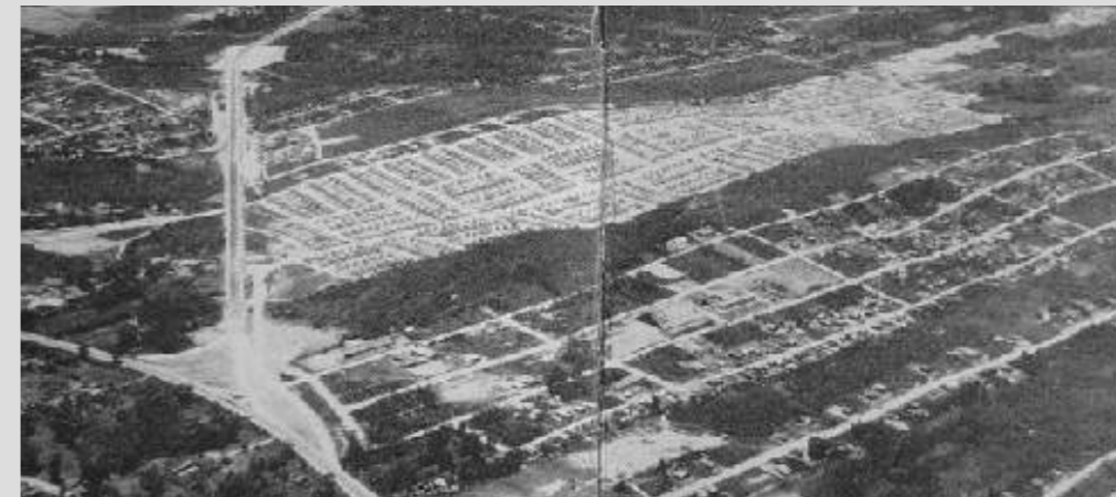
Vista aérea do conjunto habitacional Bela vista e entorno. Década de 1970. (Fonte: SILVA, 2006)
