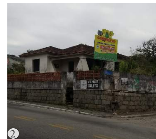
Fig 78: Edificação de esquina abandonada. (Fonte: Acervo próprio)
