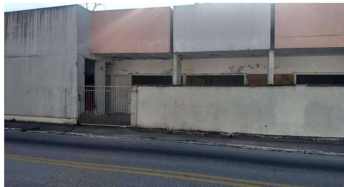
⑩ Edifício abandonado na esquina da Praça Hercílio Luz com a Rua Gaspar Neves
