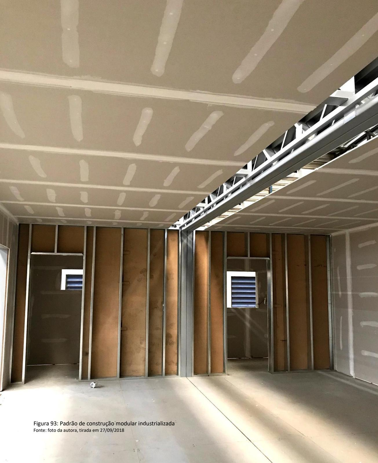
Figura 93: Padrão de construção modular industrializada
