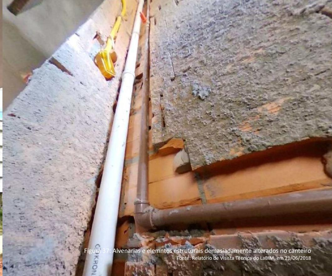
Figura 37: Alvenarias e elementos estruturais demasiadamente alterados no canteiro
