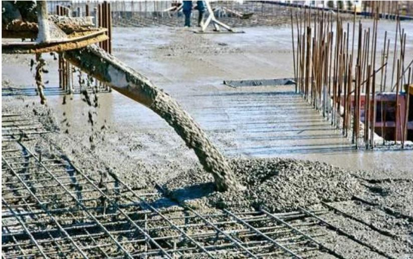
Figura 29: Construção em concreto armado
