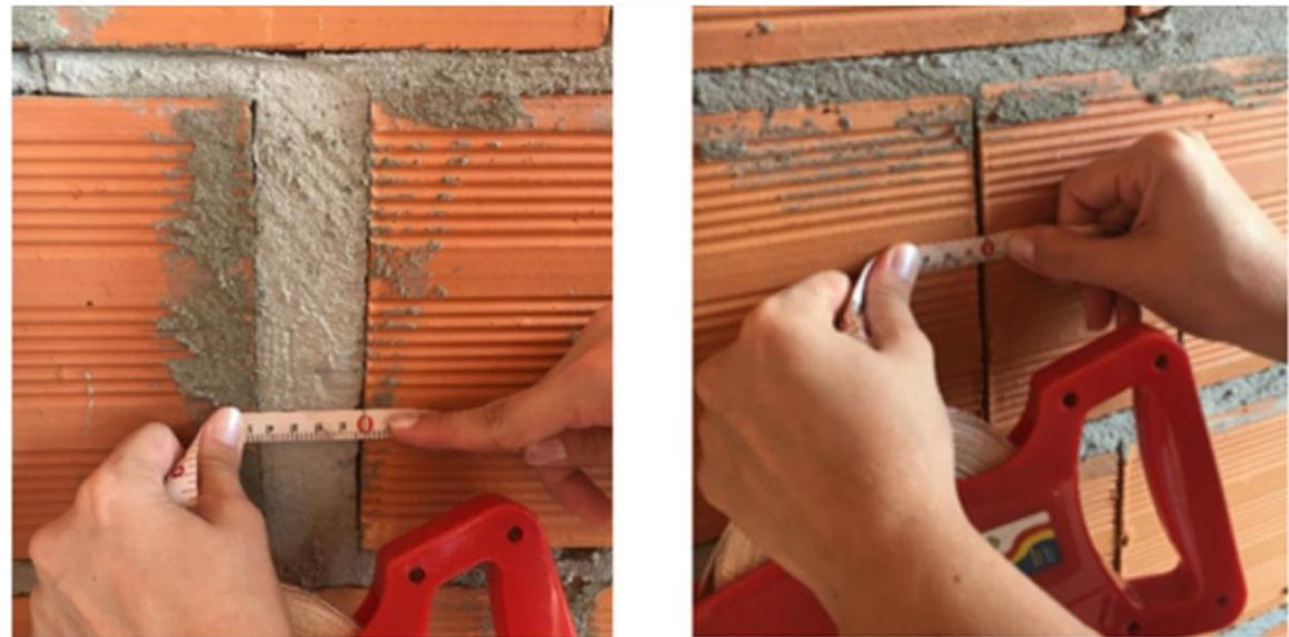
Figura 50: Juntas entre tijolos extremamente irregulares
