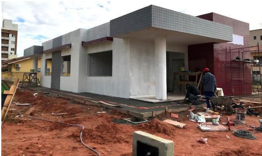
Figura 64: Canteiro desorganizado, podendo causar perda de materiais e contaminação do solo
