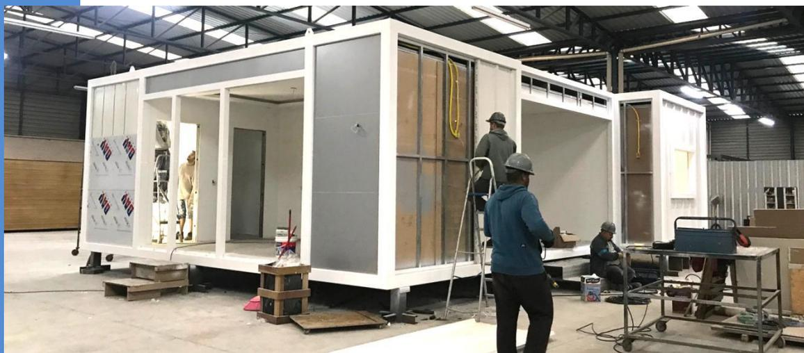
Figura 98: Modo industrializado modular de construção
