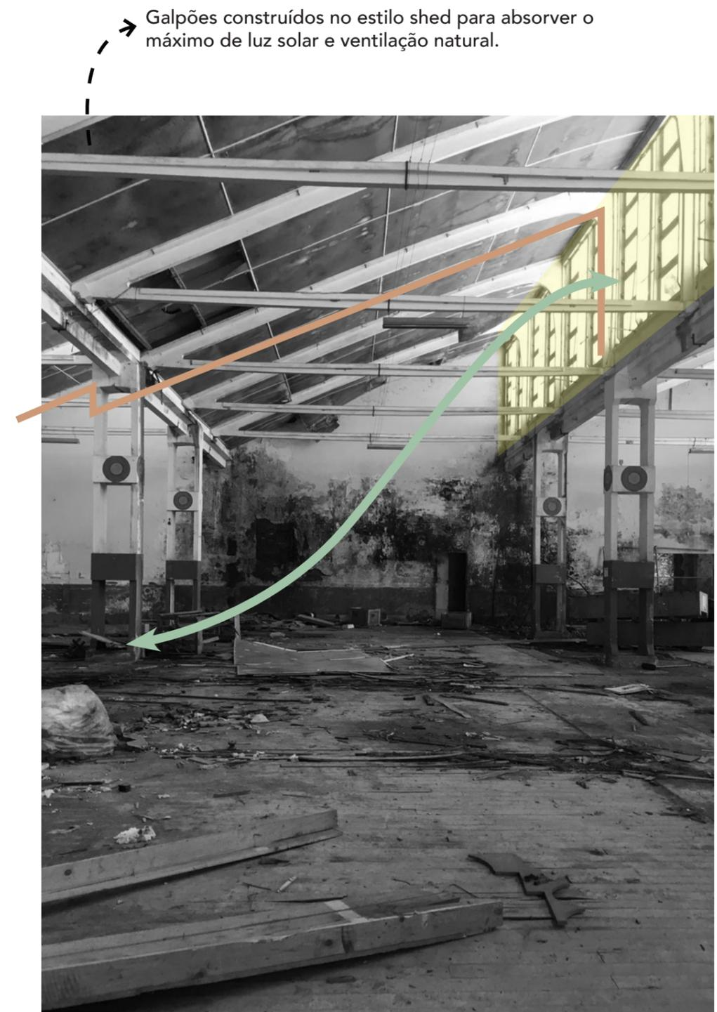
Galpões construídos no estilo shed para absorver o máximo de luz solar e ventilação natural.
