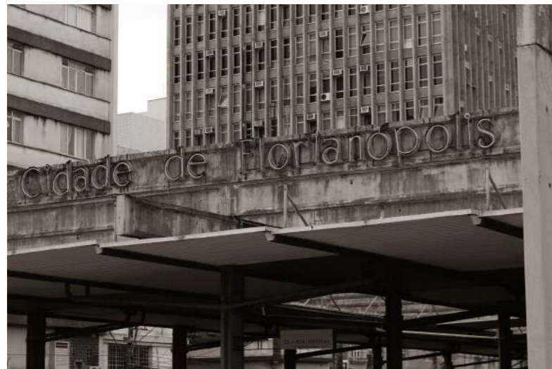
antigo terminal do centro de florinaópolis, 2016. acervo da autora.
