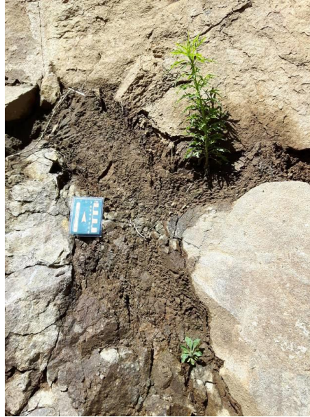
Figura 34. Solo argiloso compactado preenchendo as discontinuidades do talude são (IGUATEMI CONSULTORIA E SERVIÇOS EM ENGENHARIA LTDA, 2016).
