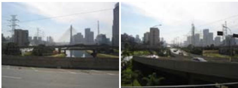
Figuras 31 e 32 – Ponte do Morumbi
