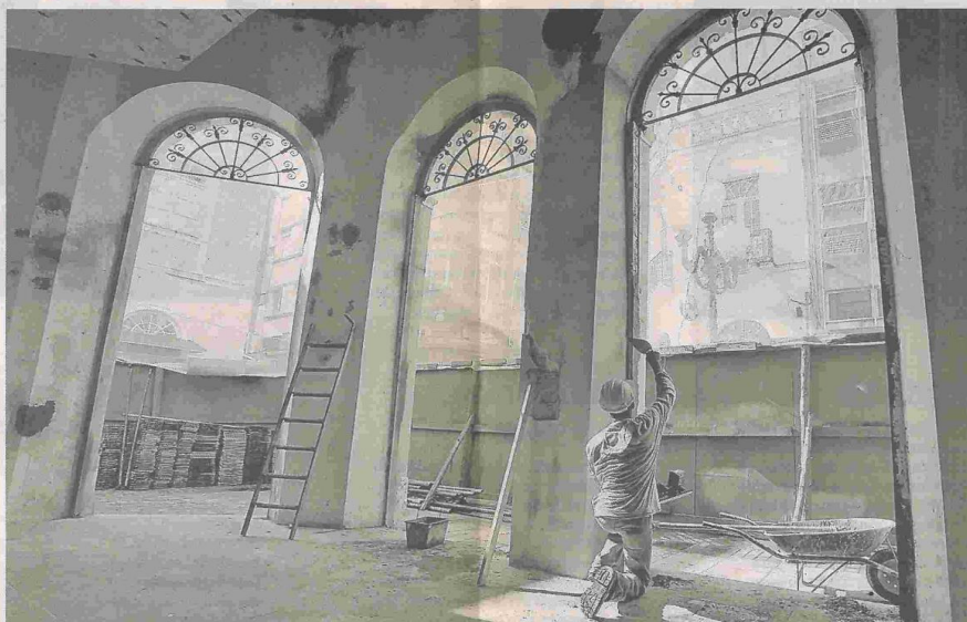
Estruturas que receberão as novas portas, mais espessas mas com as mesmas características das antigas, estão na etapa final
