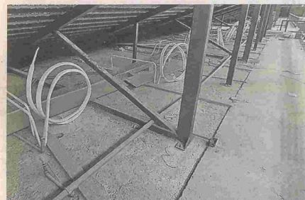
Patrimônio ganhou fiação para instalação de ar-condicionado, refrigeração será padronizada
