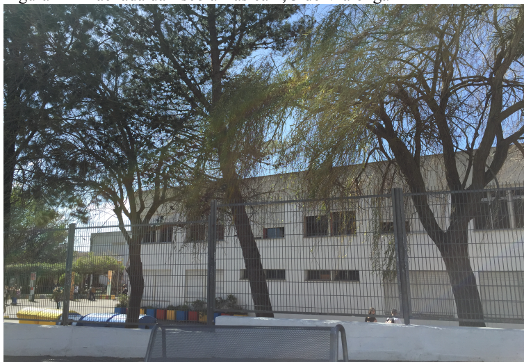
Figura 11 - Fachada da Escola Básica 2, 3 de Vialonga
