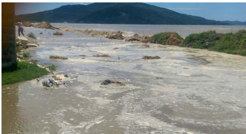
Figura 25. Dique parcialmente destruído no bairro da Praça (Tijucas). Fonte: portal TopElegance (2016).
