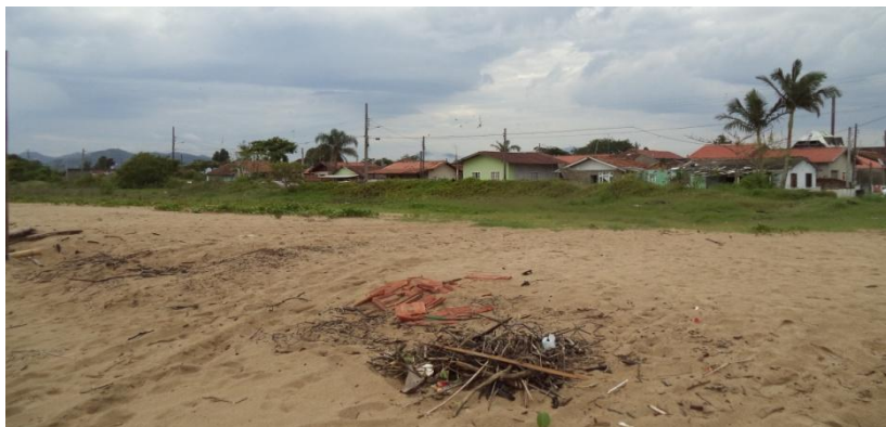
Figura 30. Nos setores onde o dique está conservado e com vegetação as residências não foram atingidas. Foto: Elaine Santos (2016).
