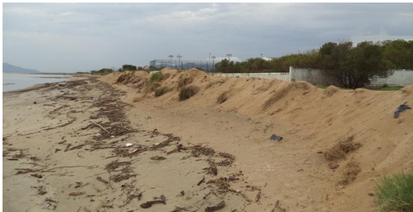
Figura 28. Dique parcialmente reconstruído no bairro da Praça após o evento. Foto: Elaine Santos (2016).
