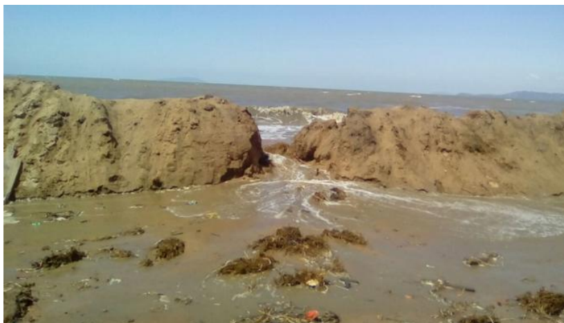
Figura 19. Dique não vegetado no bairro da Praça sendo destruído devido ao evento. Fonte: VipSocial (2016).
