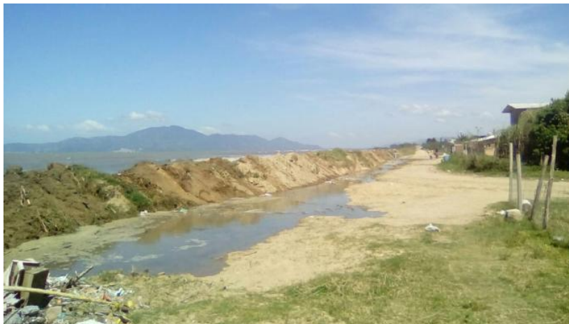
Figura 18. Dique não vegetado no Bairro da Praça sendo sobrelavado no evento de 15/09/2016. Fonte: VipSocial (2016).
