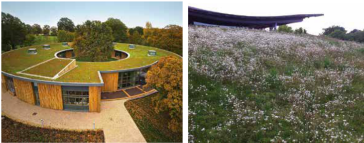
Figura 3. Exemplos de telhados verdes com vegetação extensiva.
