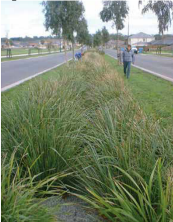
Figura 12. Trincheira de biorretenção.
