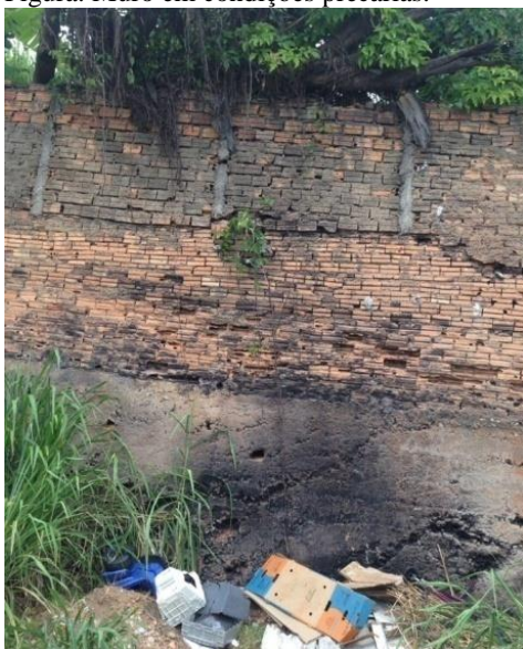
Figura: Muro em condições precárias.
