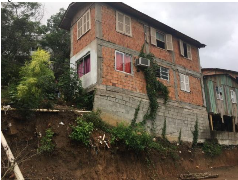
Figura: Deslizamento no talude recortado.
