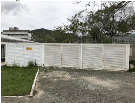
Figura 19 - Central de gás do RU
