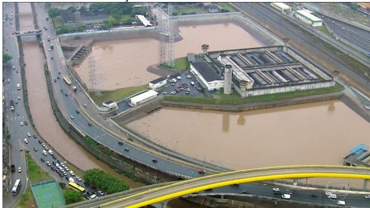
Figura 3 - Reservatório de retenção em São Paulo/SP
