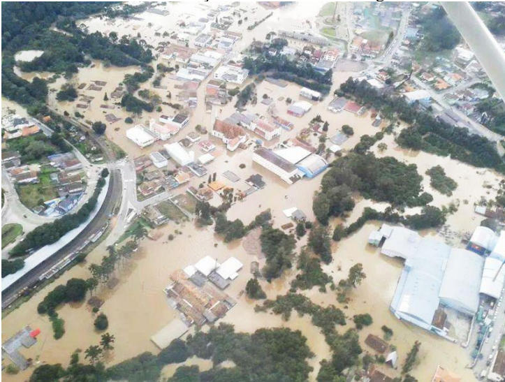
Figura 2 - Vista aérea das inundações de 2014 em Rio Negrinho/SC
