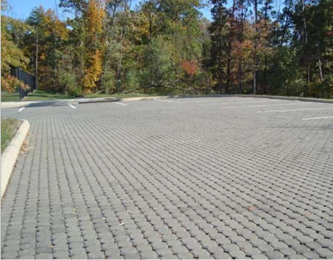
Figura 27 - Estacionamento com Pavimento Permeável
