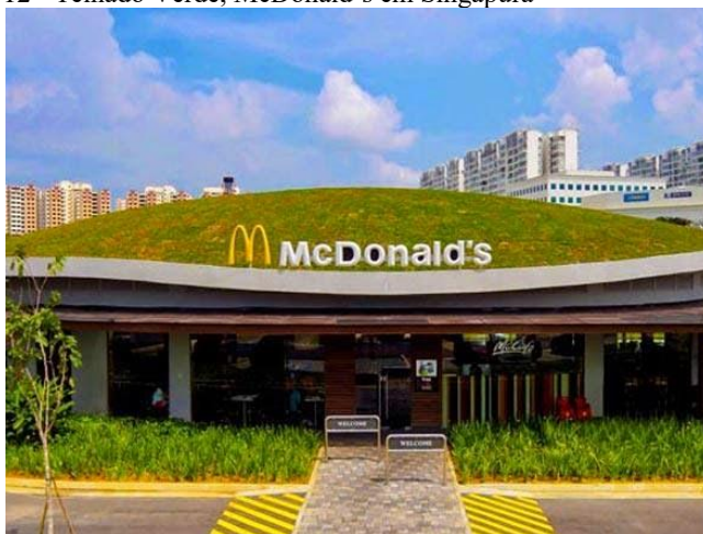
Figura 12 - Telhado Verde, McDonald's em Singapura
