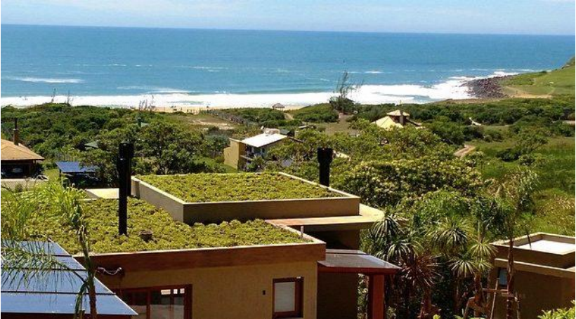
Figura 29 - Telhado Verde Região Litorânea
