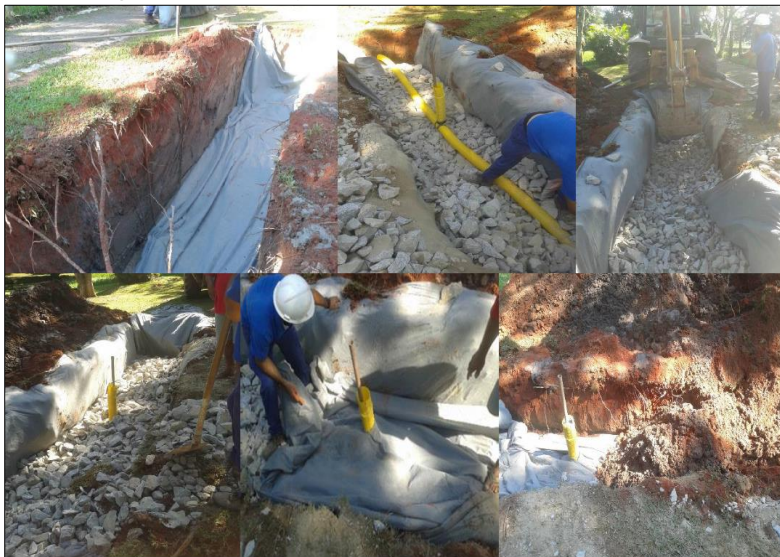
Figura 5- Construção da vala de infiltração
