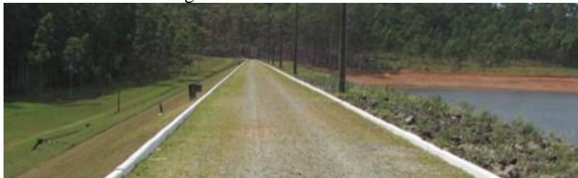
Figura 18 Crista do barramento
