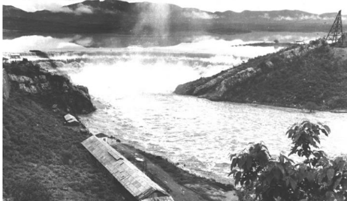
Figura 5 Barragem de Orós durante o rompimento
