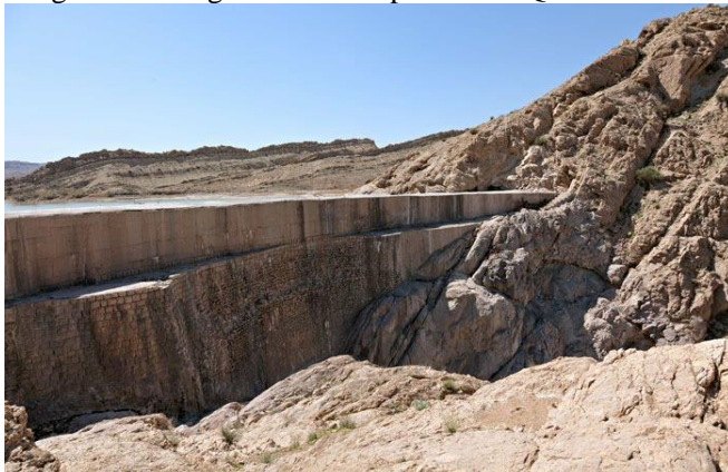
Figura 1 Barragem de Kebar próxima a Qum
