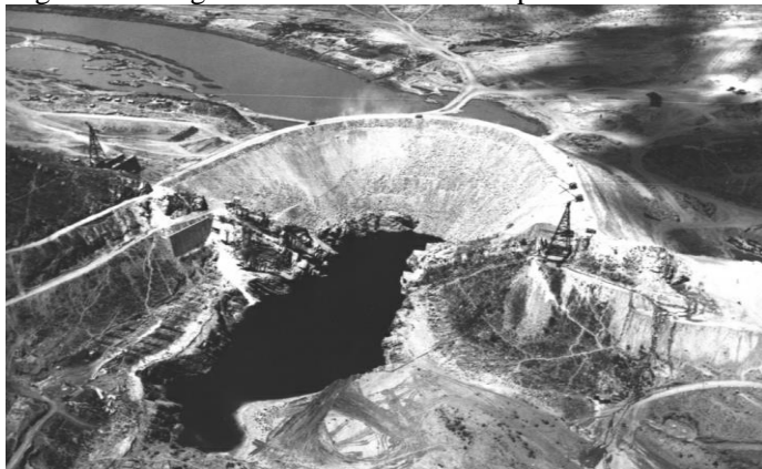
Figura 4 Barragem de Orós antes do rompimento
