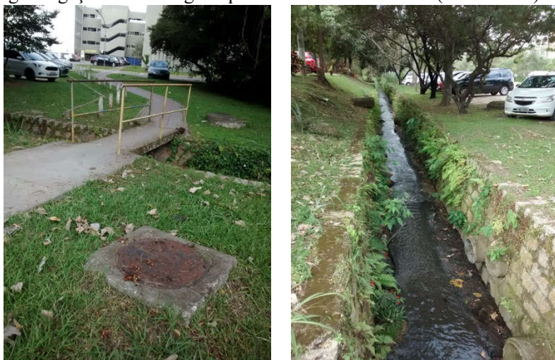
Figura 23: Poços de visita da rede de esgoto instalados próximos ao córrego e ligações de drenagem que desembocam no canal (17/05/2018).
