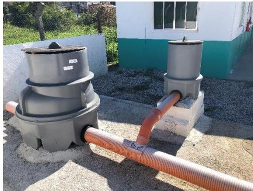
Figura 22 – Poço de visita e caixa de inspeção em PEAD
