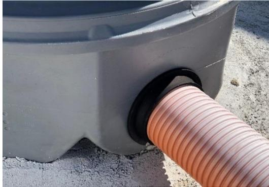
Figura 21 – Detalhe de poço de visita em PEAD
