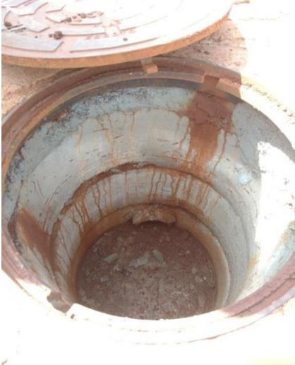
Figura 19 – Interior de poço de visita em concreto
