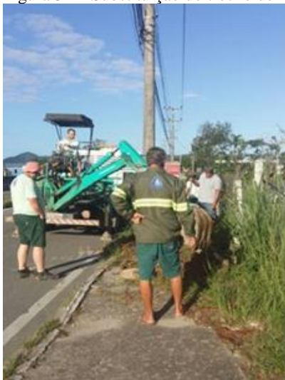
Figura 32 – Substituição do trecho de PEAD
