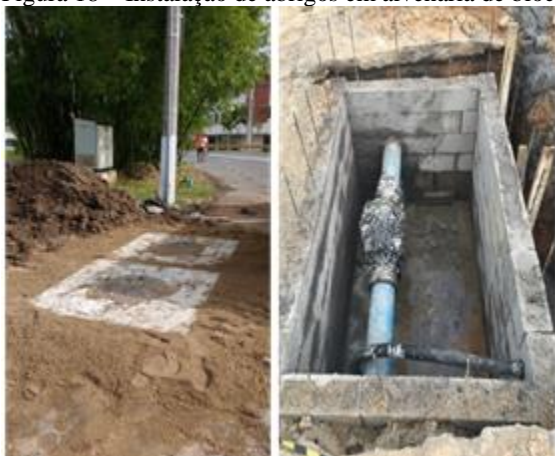
Figura 18 – Instalação de abrigos em alvenaria de blocos de concreto.
