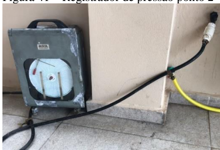
Figura 41 – Registrador de pressão ponto 2
