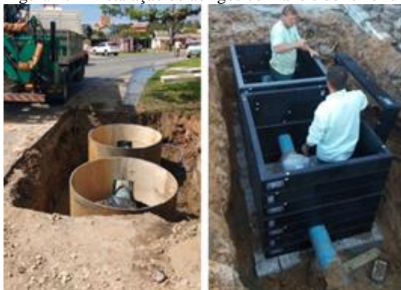
Figura 17 – Instalação de abrigos com anéis de ferro fundido e caixas de PEAD.
