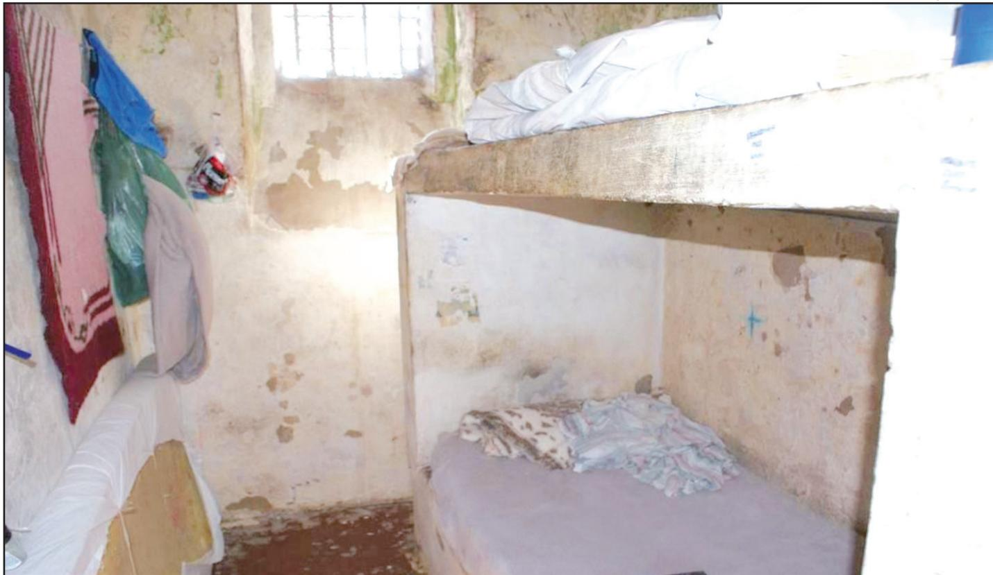
As condições precárias de iluminação, ventilação e saneamento causam excesso de mofo e umidade nas celas da Penitenciária
