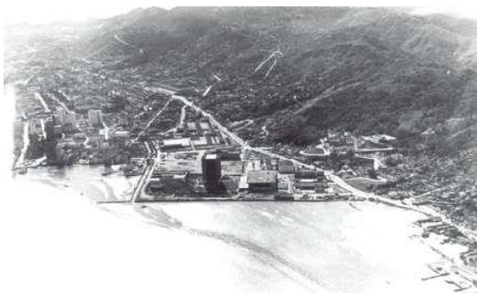
Figura 14 – Foto do 1º aterro (3ª etapa) executado na década de 1960. Já com os edifícios do Tribunal de Justiça e Assembleia Legislativa construídos ou em construção. Local: Prainha. Data: final da década de 1960. Fonte: Casa da Memória de Florianópolis.
