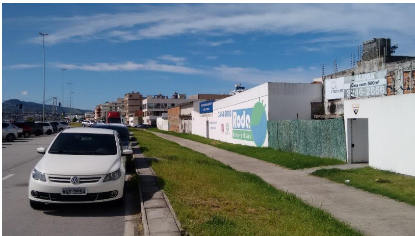
Figura 41 – Foto da vista da borda seca do aterro com fundos de lotes.
