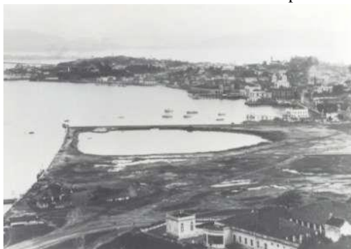
Figura 13 – Foto do 1º aterro (2ª etapa) executado na década de 1940. Local: Prainha. Data aproximada: década de 1940. Fonte: Casa da Memória de Florianópolis.
