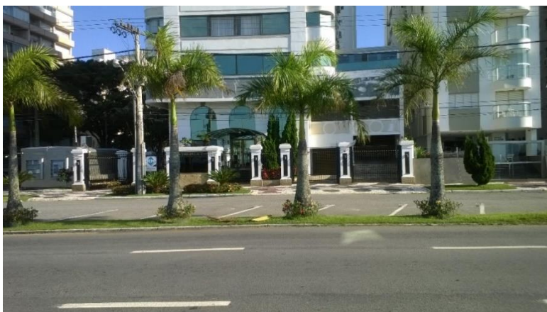
Figura 32 – Foto mostrando a configuração da maioria das portas e janelas – não proporcionam a vigilância espontânea da rua (olhos da rua) e transição suave entre público e privado.
