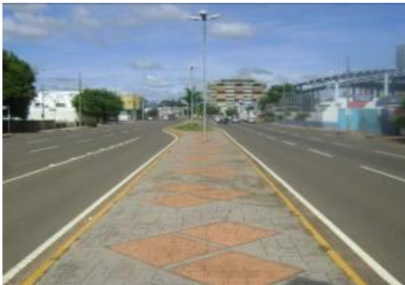
Foto 3: Córrego Prosa canalizado e tamponado no centro da foto
