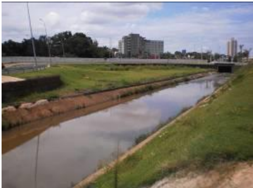
Foto 34: Retificação do córrego e bacia de retenção (piscinão)
