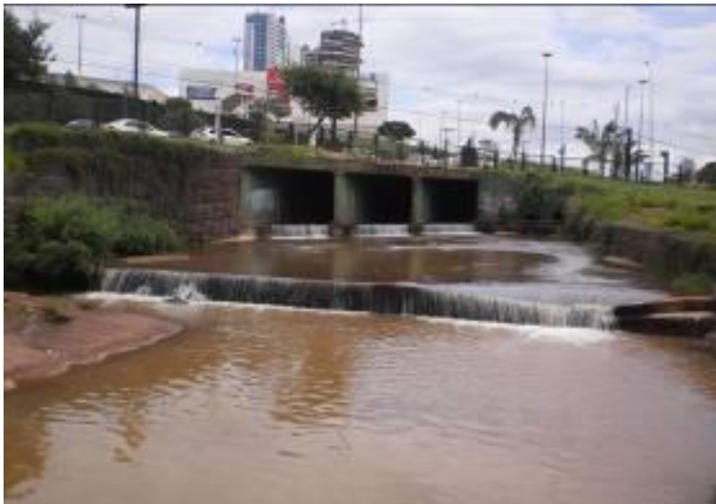
Foto 35: Córrego canalizado e tamponado nas imediações do Shopping Eldorado
