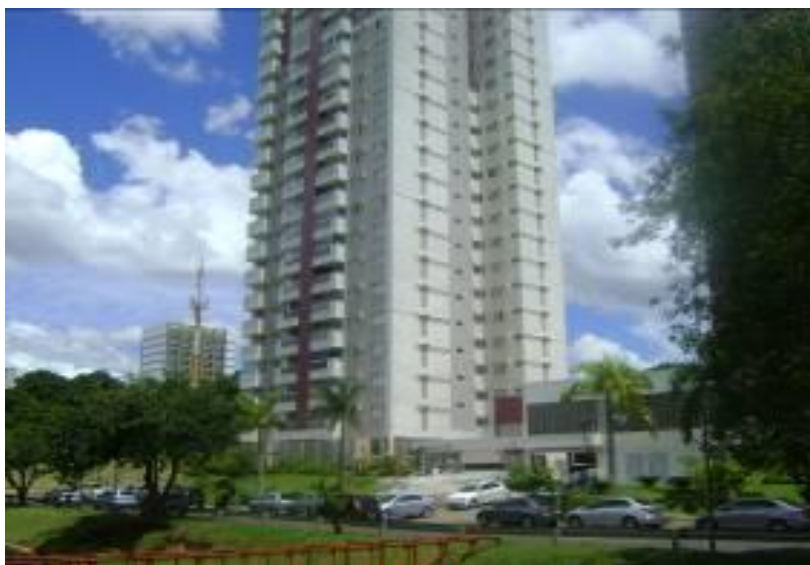
Foto 42: Condomínio residencial nas margens do córrego Prosa
