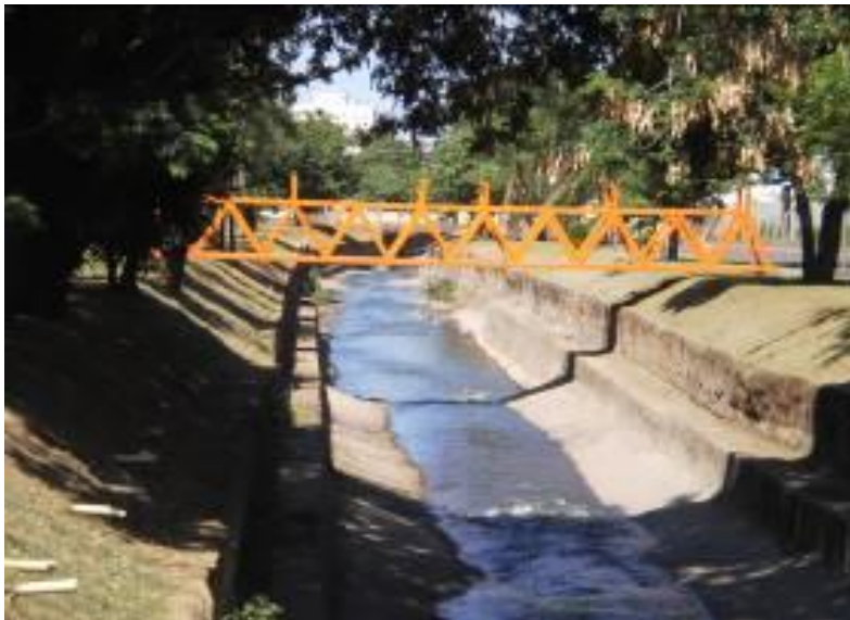
Foto 10: Passarela sobre o córrego Prosa
