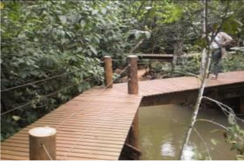
Foto 68: Passarela sobre o córrego Prosa
