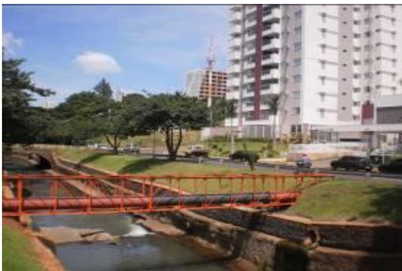
Foto 36: Vegetação exótica e duto de água da empresa Águas Guariroba
