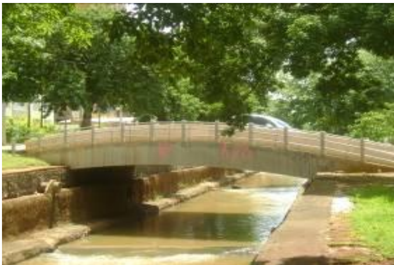
Foto 39: Ponte em arco sobre o córrego Prosa
