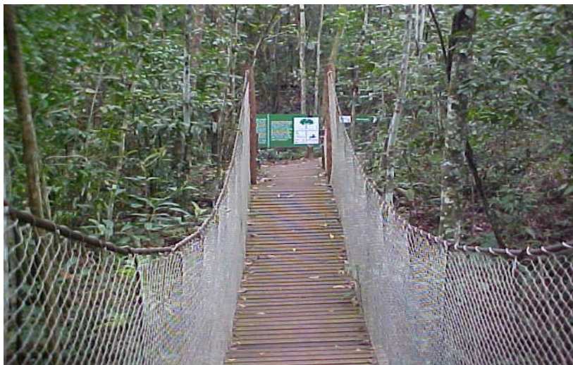
Foto 80: Passarela suspensa sobre o córrego Prosa
