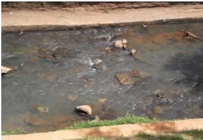
Foto 25: Revestimento do leito do córrego Prosa desgastado
