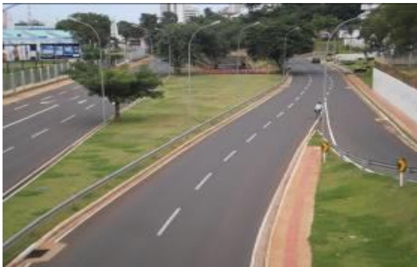
Foto 37: Córrego canalizado e tamponado nas imediações da Avenida Ceará
