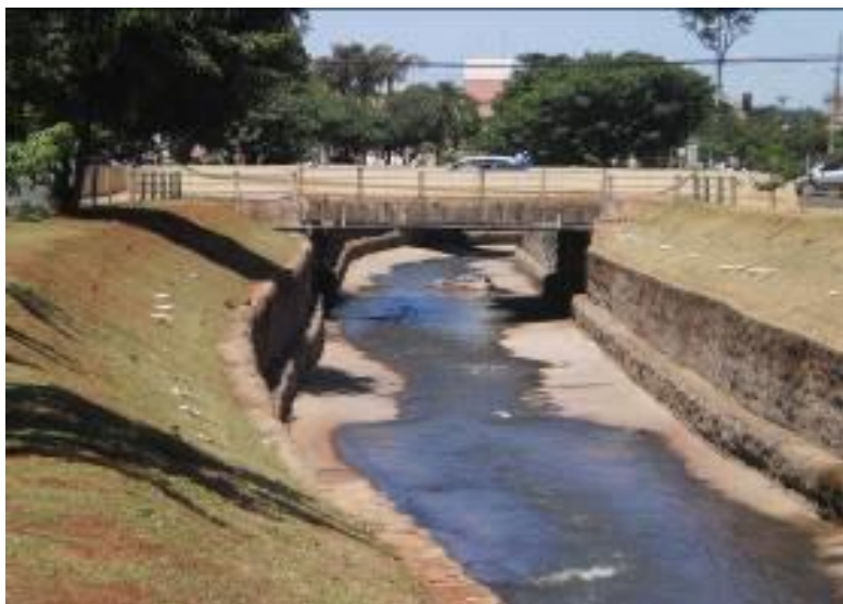
Foto 15: Córrego Prosa canalizado e retificado
