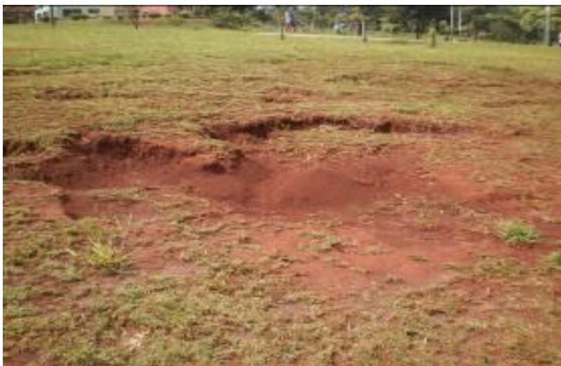
Foto 52: Erosão na margem esquerda do córrego Prosa no Parque das Nações Indígenas
