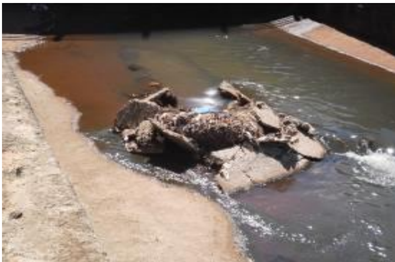
Foto 12: Resíduos sólidos no leito do córrego Prosa
