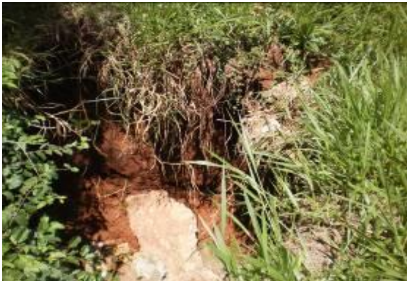
Foto 51: Erosão na margem direita do córrego Prosa no Parque das Nações Indígenas
