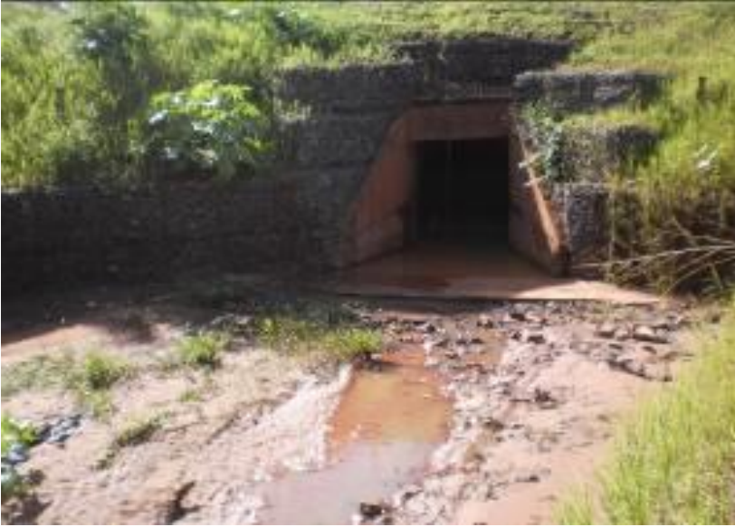
Foto 89: Córrego Joaquim Português canalizado e tamponado próximo da sua nascente
