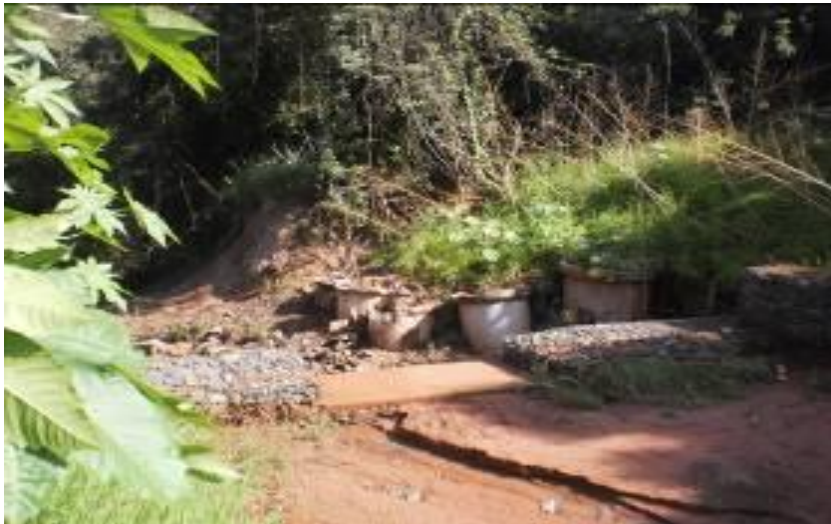
Foto 82: Barragem em gabião próximo da nascente do córrego Joaquim Português
