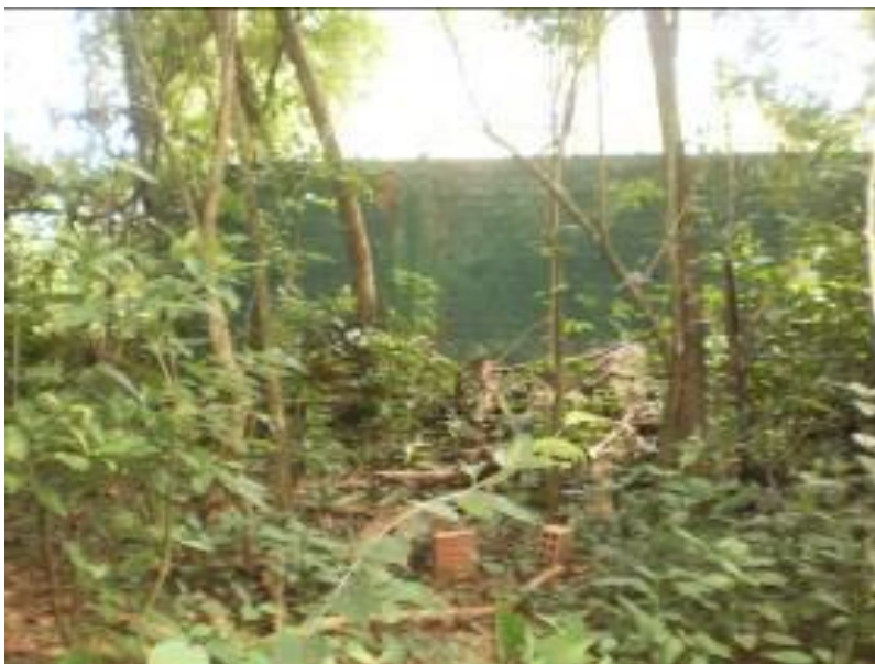
Foto 65: Muro do CRAS ao lado do córrego Prosa
