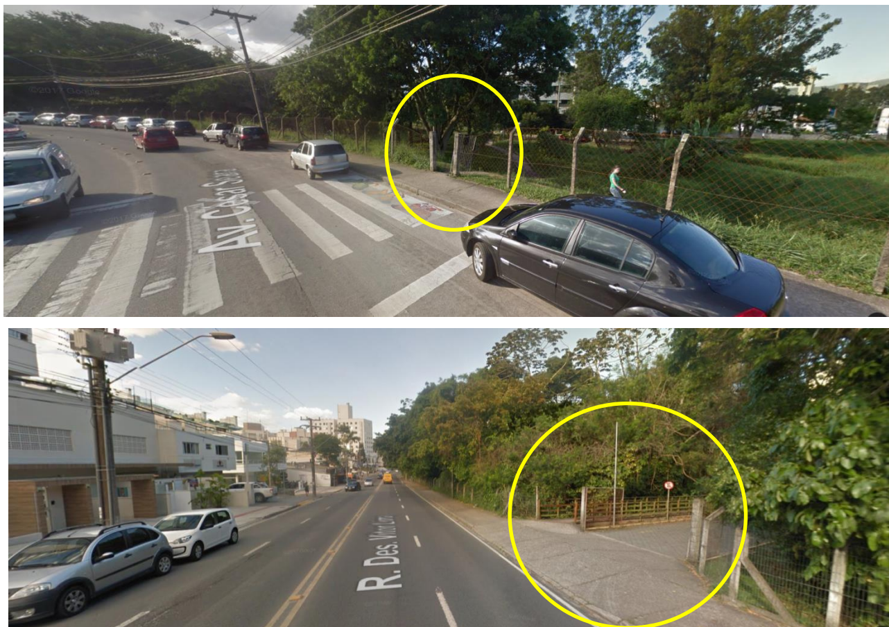
Figura 44 - Acessos não sinalizados - Campus Trindade
