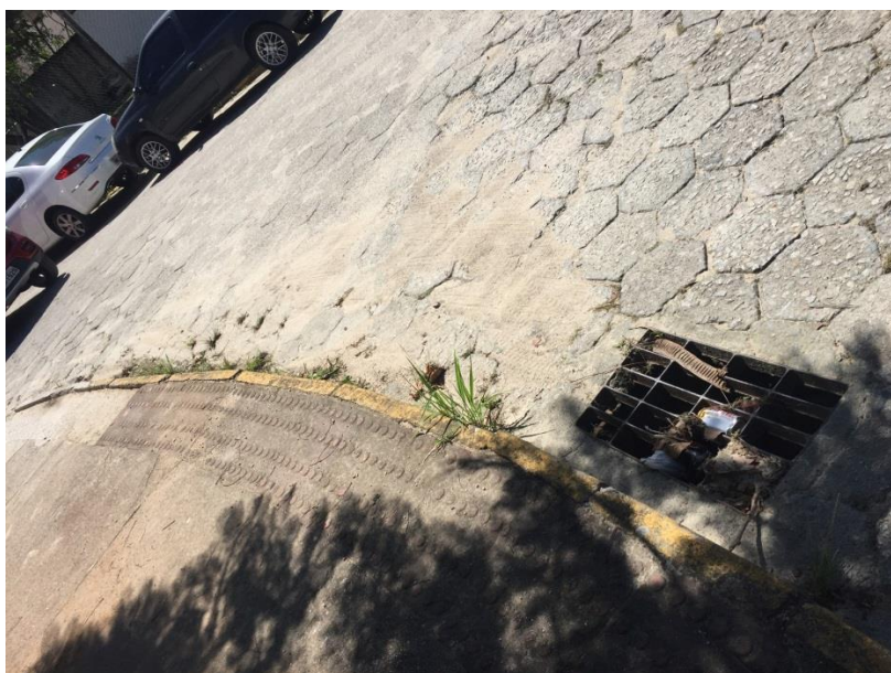
Figura 74 - Dispositivo de Drenagem - incorreta instalação longitudinal
