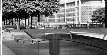
Figura 26- Muro com detalhes em aço para evitar a passagem de skates
