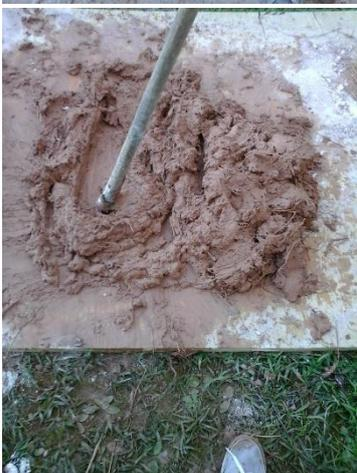
A argamassa de calfitice foi misturada manualmente com auxílio de uma enxada, por cerca de 20 minutos. Aplicou-se desmoldante DESMOL (proporção 1:5) à forma do painel e aguardou-se 1 hora de secagem para iniciar a colocação do material.
