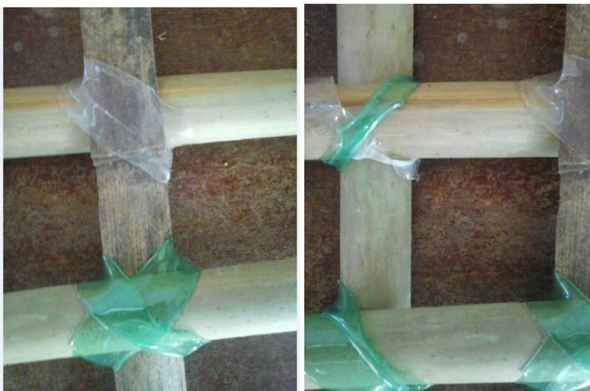
Detalhe junção entre ripas com pet já aquecidas com soprador térmico
